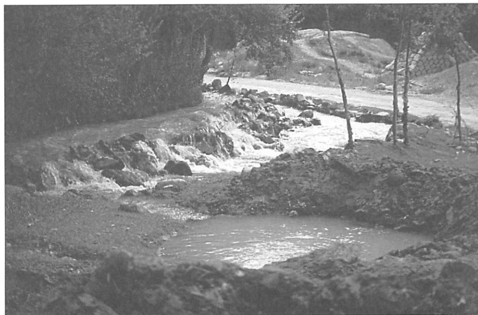
Foto 10: Überlaufvorrichtung am Marapi Hrkong ; das Becken im Vordergrund dient zum Sammeln von Sedimenten.
