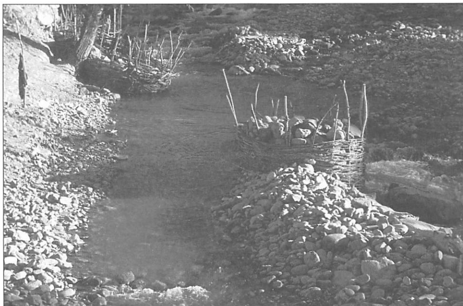
Foto 9: Abzweig des Chhogho Hrkong (= Großer Kanal) von der Shigar-Nalla ; die mit Geröll gefüllten Körbe aus Weidengeflecht stabilisieren den Kanal bei Hochwasser.
