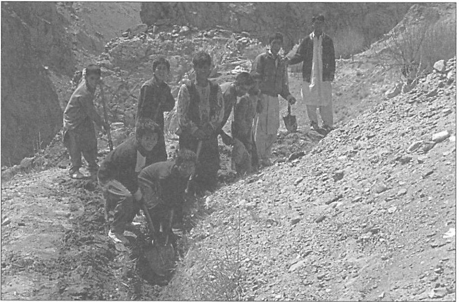
Foto 15: Im Frühjahr werden die Kanäle von Geröllen und Sedimenten befreit und repariert.
