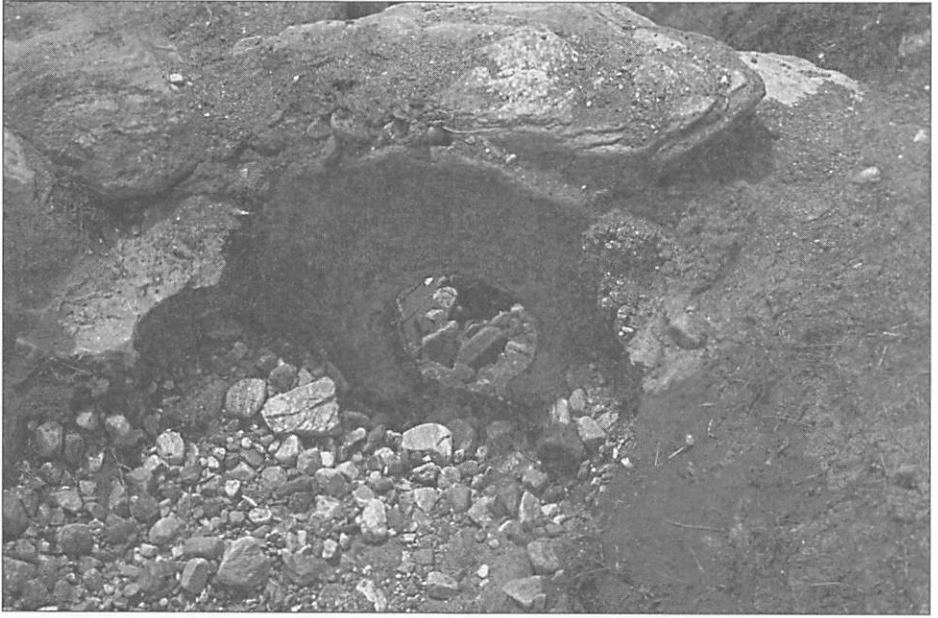
Foto 11: Traditionelle Form eines Kanalabzweigs aus bearbeiteten Steinen ( rzamik )
