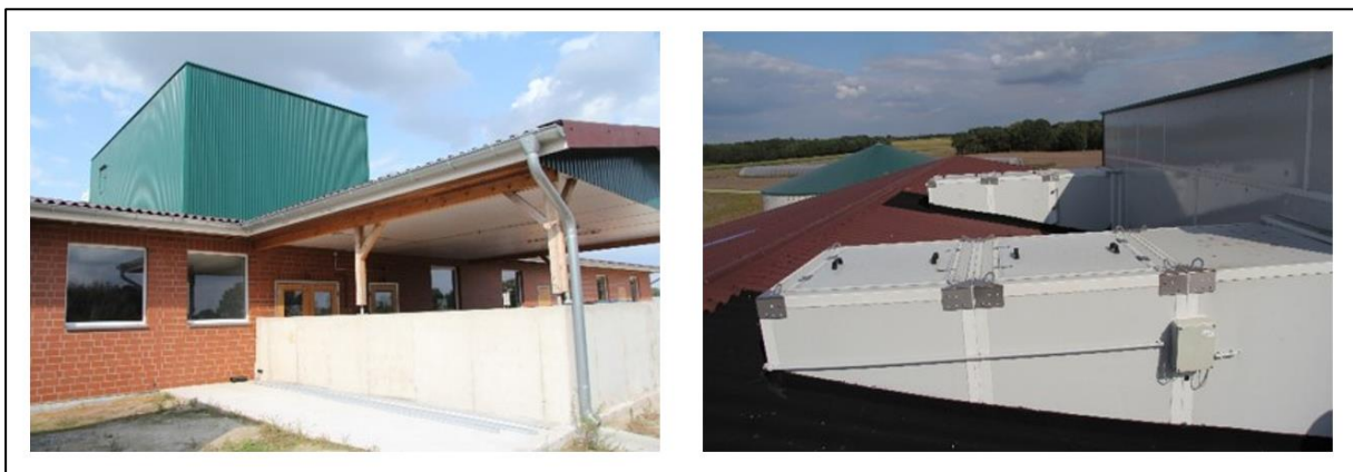
Abbildung 7: Links: Versuchsstall der Fallstudie 1 von außen mit Blick auf die im Dachraum befindliche Abluftreinigungsanlage. Rechts: Dachansicht der beiden der Abluftreinigungsanlage vorgeschalteten Wärmetauscher ©Deeken
