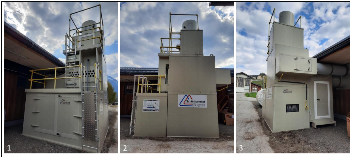
Abbildung 15: Tauschwäscher am Versuchsbetrieb der HBLFA Raumberg-Gumpenstein von links (1), von vorne (2) und von rechts (3) fotografiert. ©Lengling
