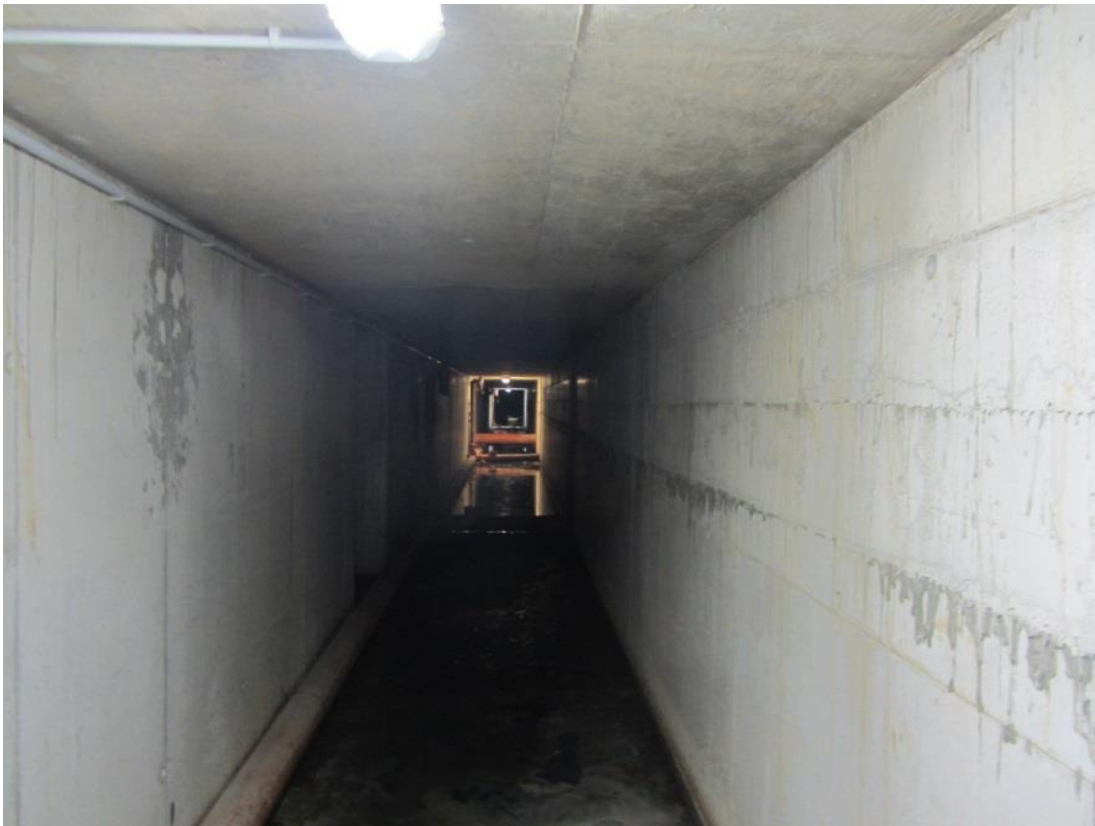
Abbildung 16: Blick in den Zentralkanal (POMMER, 2015)
