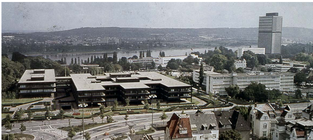
Abb. 8.9+8.10: Zustand des Regierungsviertels 1987 (nach Errichtung des Bundeskanzleramts 1972) Sinnlosigkeit zu Recht mit einer Skulptur von Henry Moore kompensiert wurde. Es dürfte schwerfallen, angesichts der Kanzleramtskehrseite überhaupt eine Selbstdarstellung von Demokratie zu sehen 97 .
