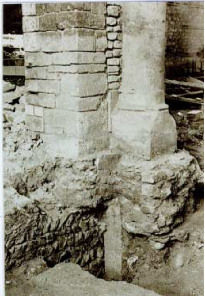
ABBILDUNG 10 DER SÜDLICHE PFEILER ZWISCHEN DEM 3. UND 4. JOCH MIT FUNDAMENTMAUER IM OPUS SPICATUM UND VORGESTELLTER GOTISCHER SÄULE (GRABUNGSPHOTO VON 1987)
