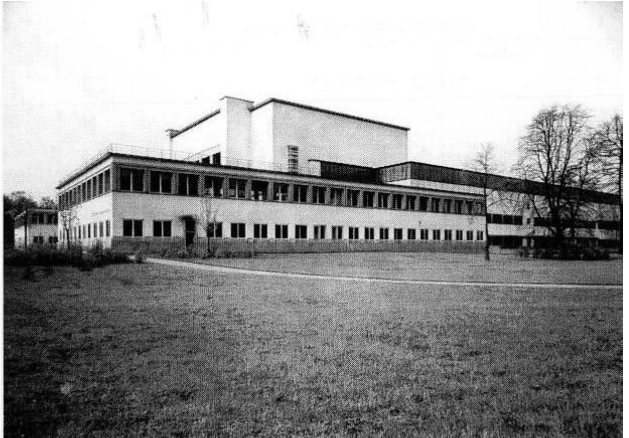
Abb. V/35 Nördliche Seitenansicht, Fassade des nördlichen (rechten) Kopfbaus
