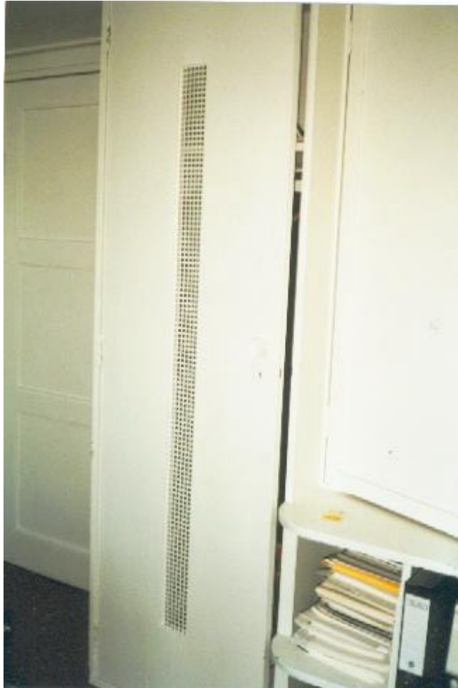
Abb. VI/23 Einbauschränk, Büroraum im nördlichen (rechten) Kopfbau (Foto 1990er Jahre)
