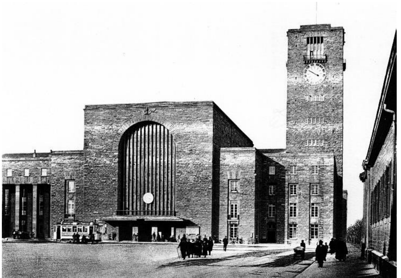
Abb. VIII/8 Paul Bonatz, Bahnhofsgebäude Stuttgart
