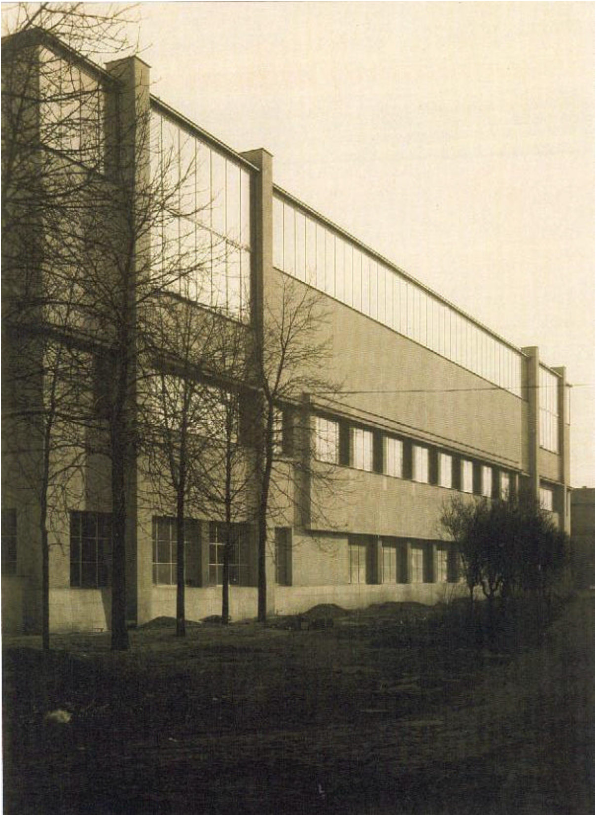
Abb. V/44 Rückwärtiger Querbau, Zinzendorfstraße
