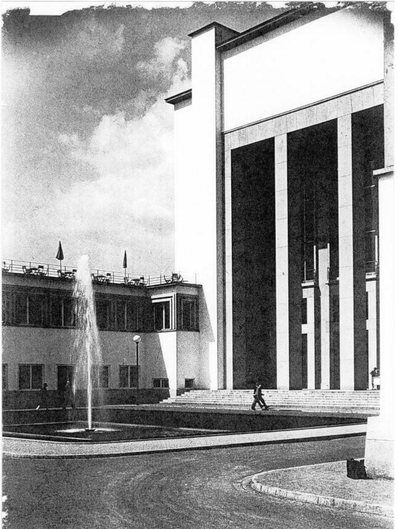
Abb. V/26 Ehrenhof, Innenseite des südlichen (linken) Kopfbaus mit Winkelbau (um 1930)
