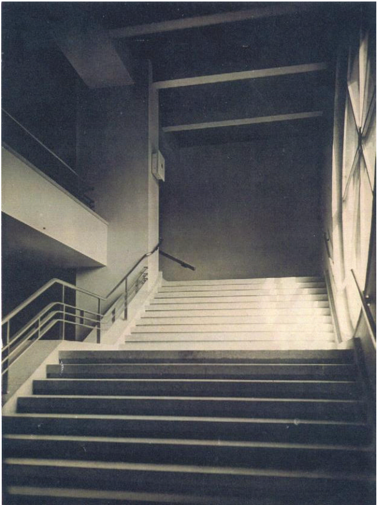
Abb. VI/172 Treppenhaus im vorderen Teil des nördlichen (rechten) Hofflügels mit Kreisfenster
