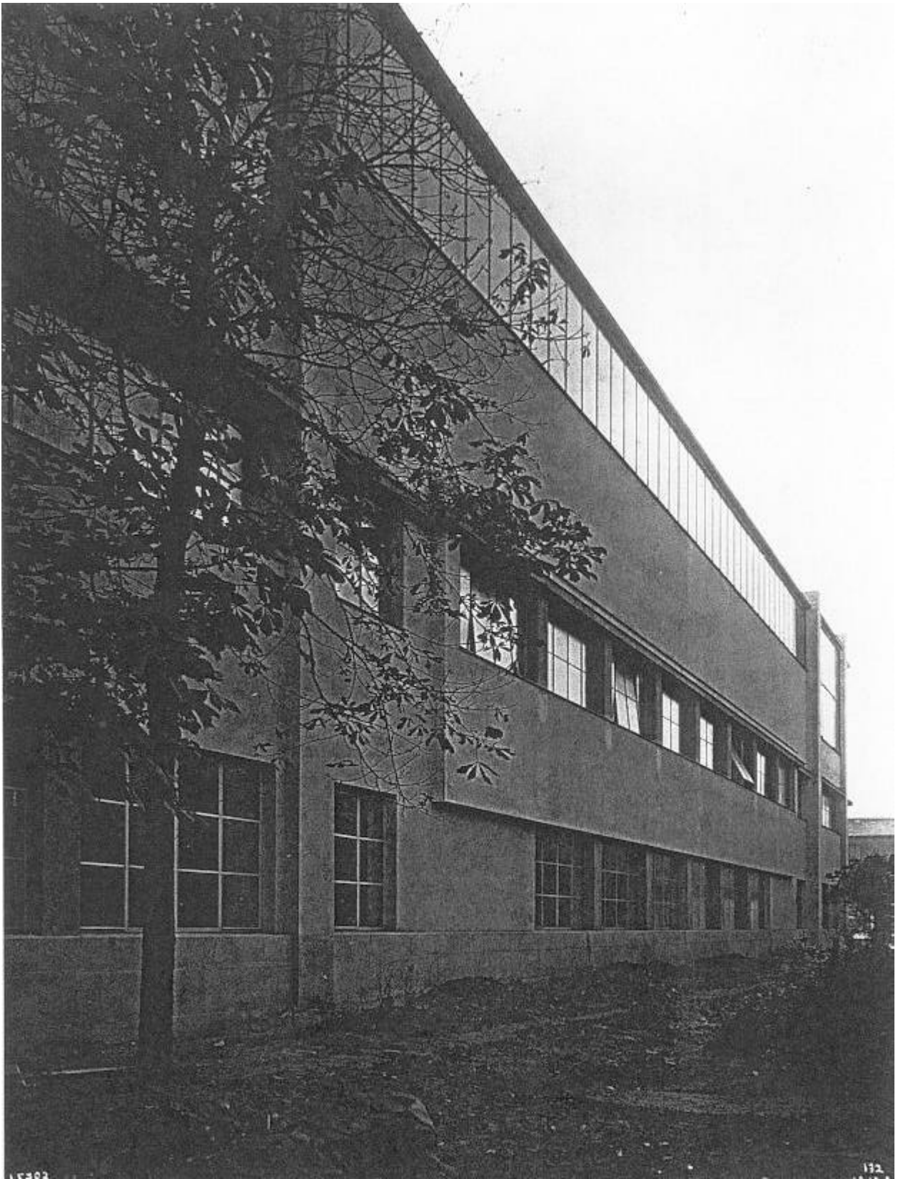
Abb. V/45 Rückwärtiger Querbau, Zinzendorfstraße
