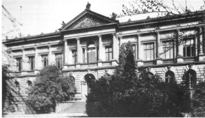
Abb. 9 Bonn: Ansicht des Altbaus von 1893
