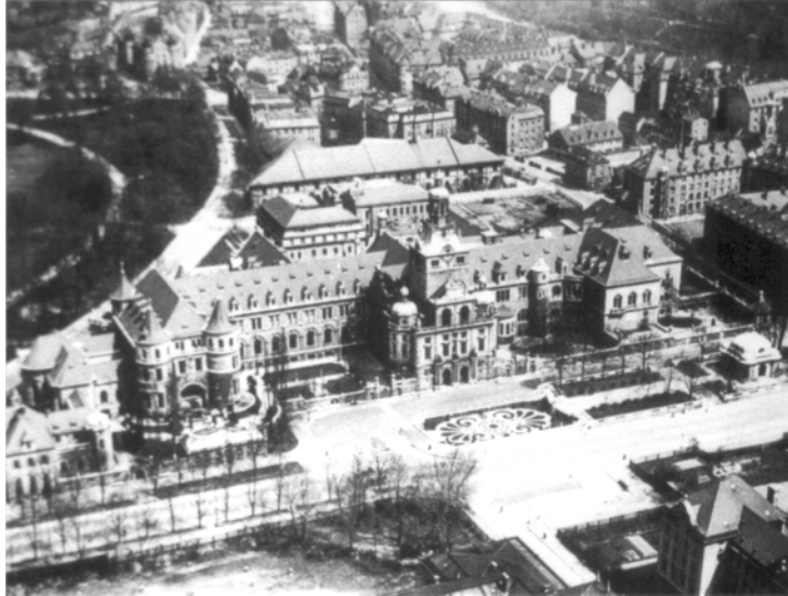
Abb. 15 München: Ansicht Seidl-Bau an der Prinzregentenstraße um 1925
