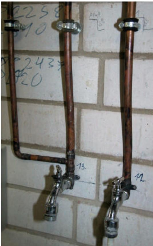
Bild 4.1.9.1.1: Leitungsführung gemäß Arbeitsblatt W 552 zur Vermeidung von Stagnationsbereichen: Der Zirkulationsrücklauf (links) zweigt unmittelbar vor der Entnahmemarmatur von der zuführenden Warmwasserleitung (mitte) ab. Die Länge des verbleibenden, nicht durchströmten Restabschnitts beträgt somit nur wenige Zentimeter. Rechts: Kaltwasser.
