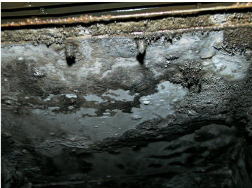
Bild 4.4.1.2: Innenseite eines Fortluftschachts aus einem RKW mit starken Ablagerungen
