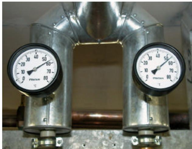
Bild 4.1.9.1.2: Betriebsweise gemäß Arbeitsblatt W 552. Die Temperatur im Zirkulationsrücklauf, d.h. nach Passage des gesamten Hausinstallationssystems, beträgt vor der Wiedererwärmung im Boiler immer noch über 55°C.
