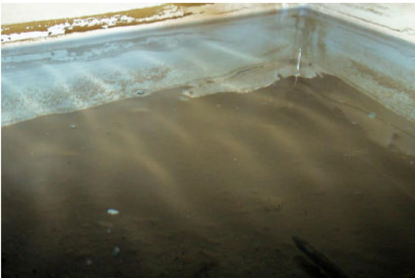
Bild 4.4.1.1: Kühlwasserwanne eines offenen Rückkühlwerks mit starken Schlammablagerungen
