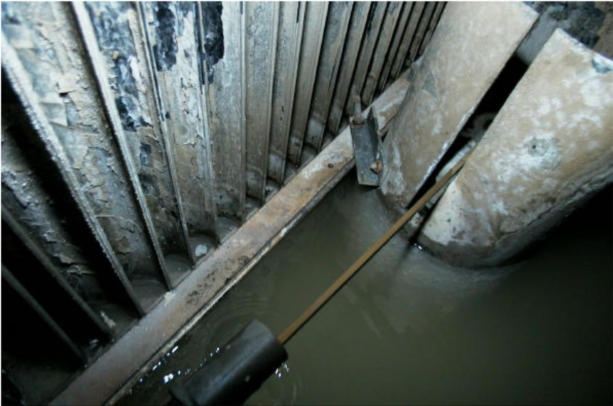
Bild 4.3.1.1: Wäscherkammer einer RLT-Anlage. Links oben: Lamellen des Tropfenabscheiders, stark inkrustiert und mit (angetrocknetem) Bewuchs belegt. Rechts unten: Sammelwanne der Wäscherkammer mit stark eingetrübtem Befeuchterwasser
