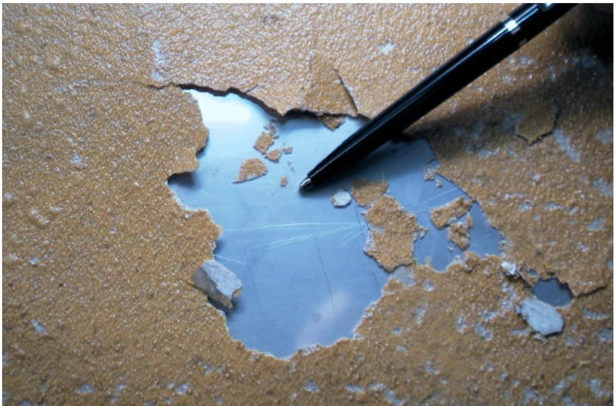
Bild 4.3.1.2: Türinnenseite der Wäscherkammer: Angetrockneter Bewuchs, für den Vergleich mit der eigentlichen Türoberfläche teilweise entfernt
