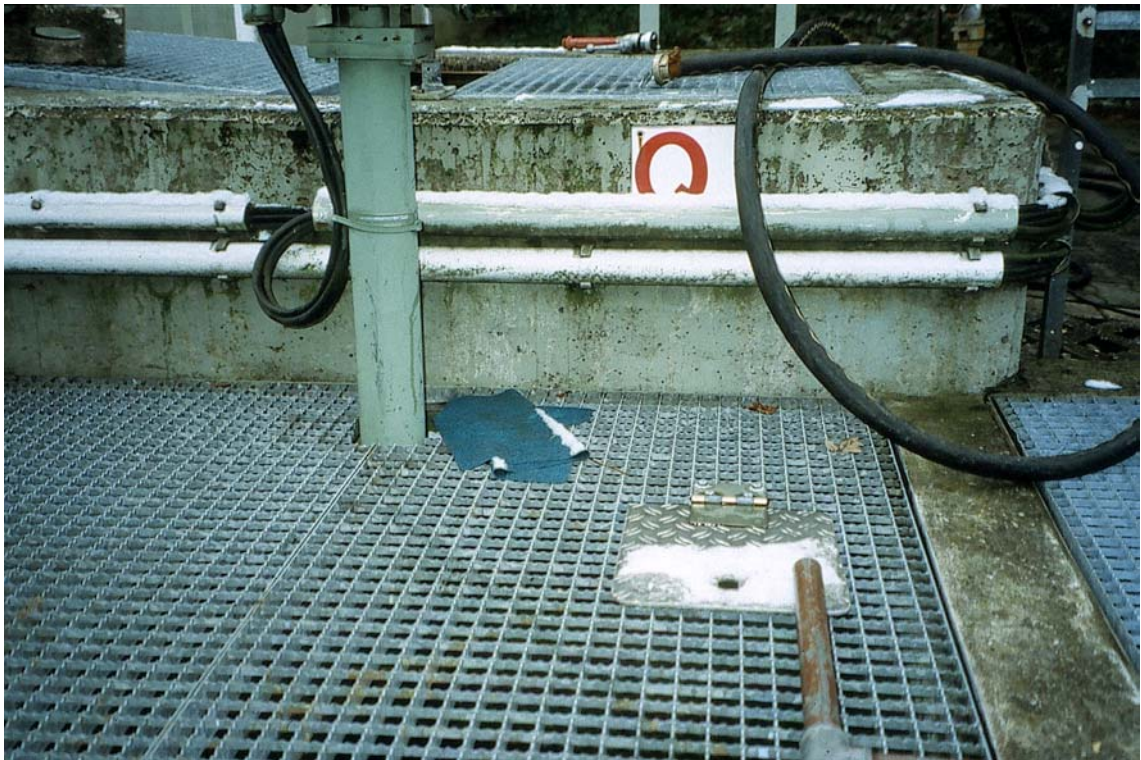
Foto 5: Ablauf Kläranlage Hillesheim
