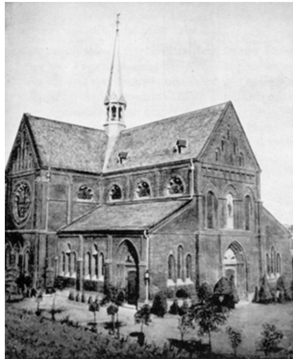
Abb. 1.17 b St. Sebastian in Bonn-Poppelsdorf, Erster Bauabschnitt von Franz Langenberg, 1889 bis 1908
