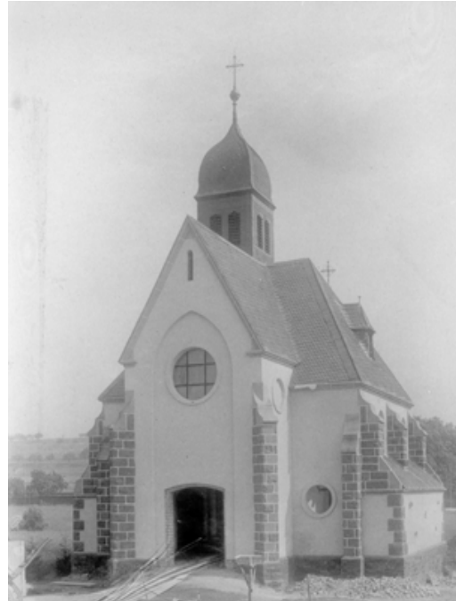
Abb. 1.13 c St. Bonifatius in Neuwied-Niederbieber, Ansicht von Nordwesten, um 1905
