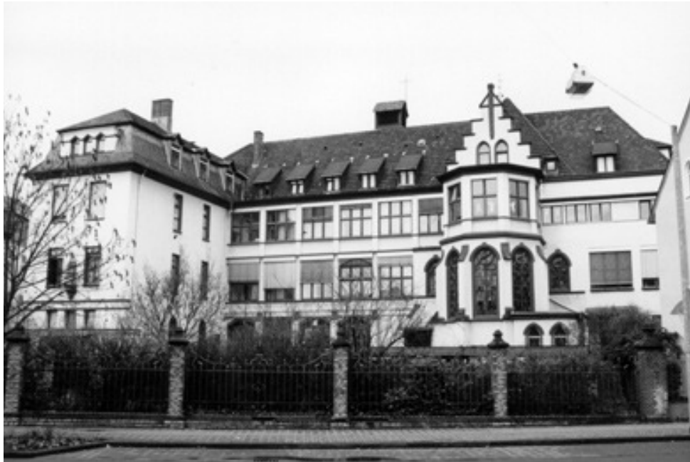
Abb. 2.02 a St. Elisabeth-Krankenhaus in Neuwied, Hauptfassade an der Engenser Landstraße, 2001
