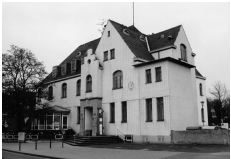
Abb. 3.04 a Ehemalige Rentei und Rathaus in Türnich, Ansicht von der Heerstraße, 2003
