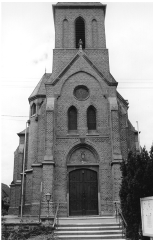
Abb. 1.10 b St. Pankratius in Rövenich, Ansicht der Eingangsfassade, 1998
