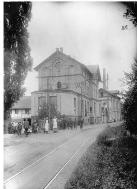
Abb. 3.06 c Karl-Wagner-Beinwarenfabrik in Neuwied-Niederbieber, Bürogebäude, Ansicht von Süden, nach 1901
