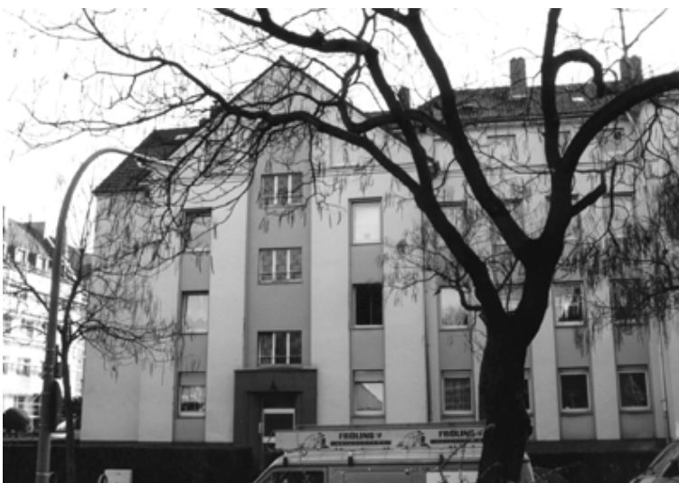
Abb. 3.19 e Heisterbachstraße 43 in Köln-Klettenberg, 2001
