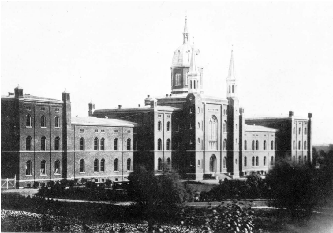
Abb. 14 Aachen, Maria-Hilf-Krankenhaus (1848/ 55) von Friedrich Ark, 1866
