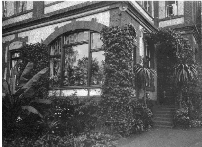
Abb. 3.15 b Villa Krings in Neuwied-Niederbieber, früherer Zugang an der Südseite, vor 1906?
