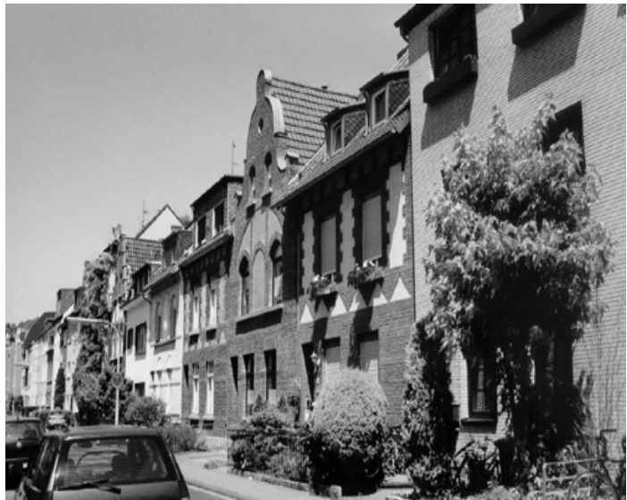
Abb. 3.18 e Wohnhäuser in der Eisenachstraße in Köln-Nippes, 2000
