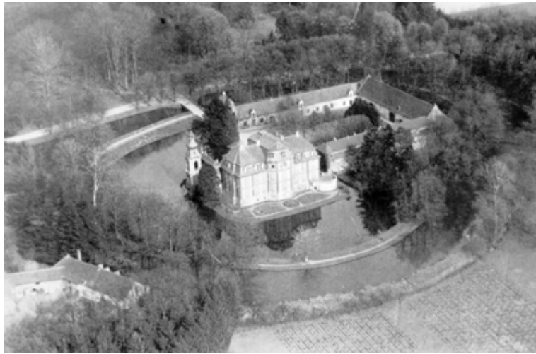
Abb. 1.03 a Schloss Türnich, Luftbild von Südwesten, 1933
