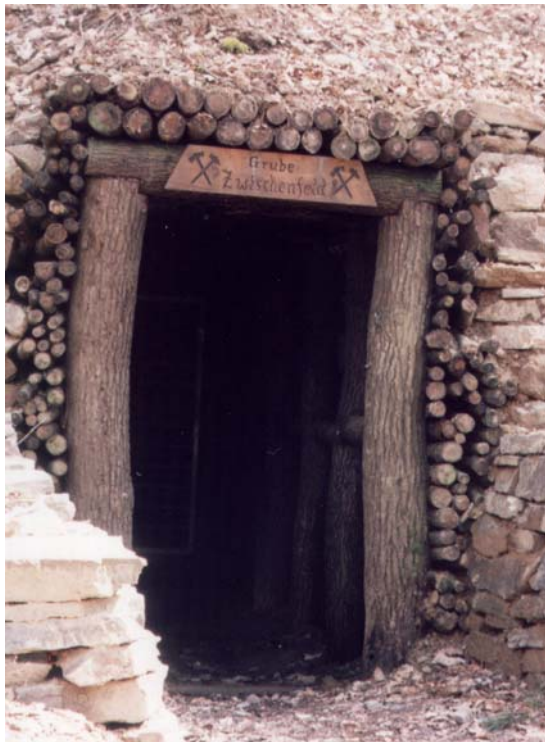
Abb. IV.2.AE12b Stollenmundloch der Grube Zwischenfeld. Rekonstruierter Erzstollen im Holzbausbau als Station des Montanwanderwegs der Erzgrube Silberhardt, Öttershagen bei Windeck (Sieg).
