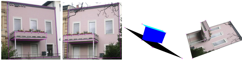
Abbildung 4.29: Ungenau rekonstruierter Balkon
