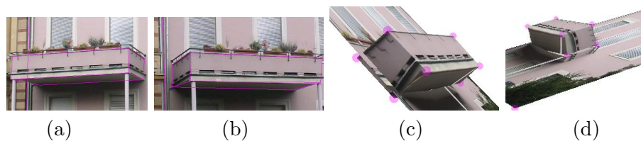
Abbildung 5.2: Photogrammetrie und Entzerrung am Beispiel eines Balkons: (a),(b) Ausgangsdaten und (c),(d) Ergebnis
