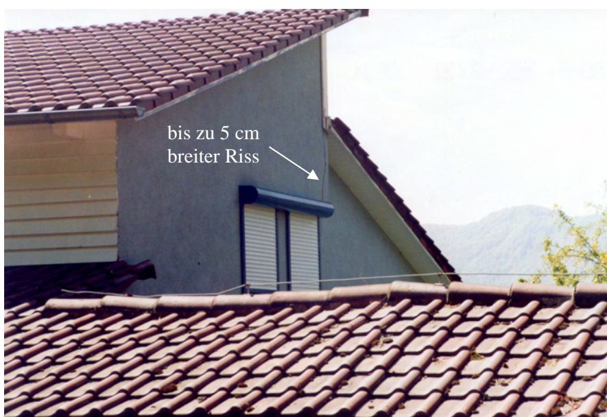
Abb. 6.20: Rissbildung am Haus von Familie Siegler im Untersuchungsgebiet Lichtenstein-Unterhausen
