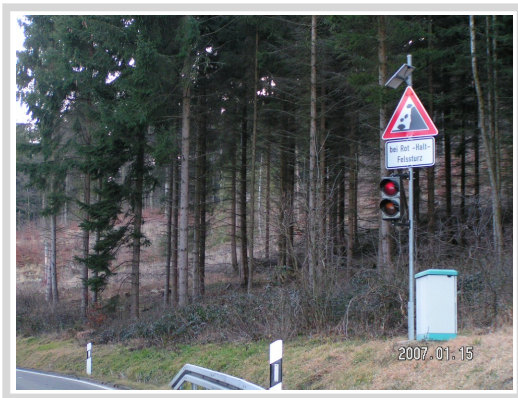
Abbildung 15.24: W Gräbelesberg, Steinschlagampel an der Kreisstraße K7145. Eigenes Foto.
