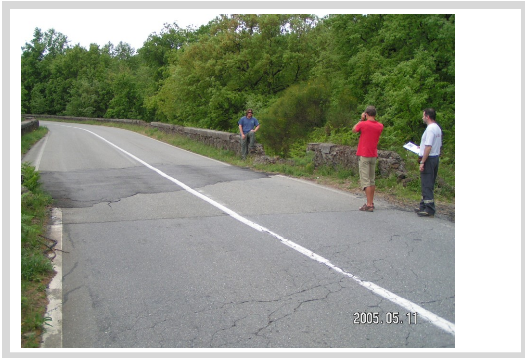
Abbildung 15.11: Versatz einer Straße am E-Hang des Ätna durch eine Rutschung nach dem Ausbruch 2002, zu erkennen an den weißen Seiten- und mehrfach nachgezeichneten Mittellinien, dem Versatz der Mauer rechts im Bild und der Auffüllung der Stufe in der Mitte des Bildes. Die Rutschung ist weiter aktiv, wie an dem aufgerissenen Asphalt zu erkennen ist. Eigenes Foto.
