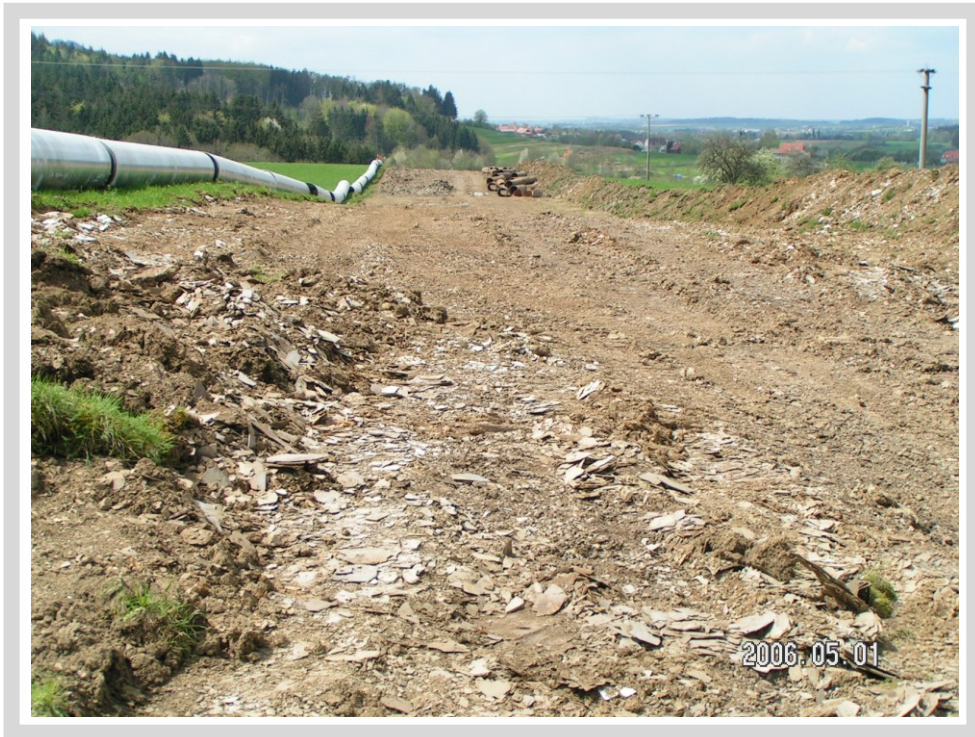
Abbildung 15.16: Geologischer Pfad Schwäbisch Gmünd, N Rechberg, Verebnungsfläche des Posidonienschiefers. Bau einer Wasser-Pipeline. Eigenes Foto.
