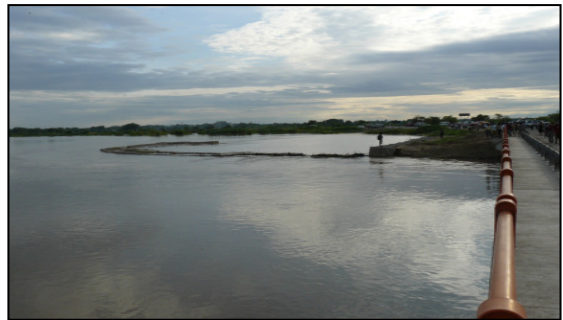
Puente Independencia, Feb.2008
