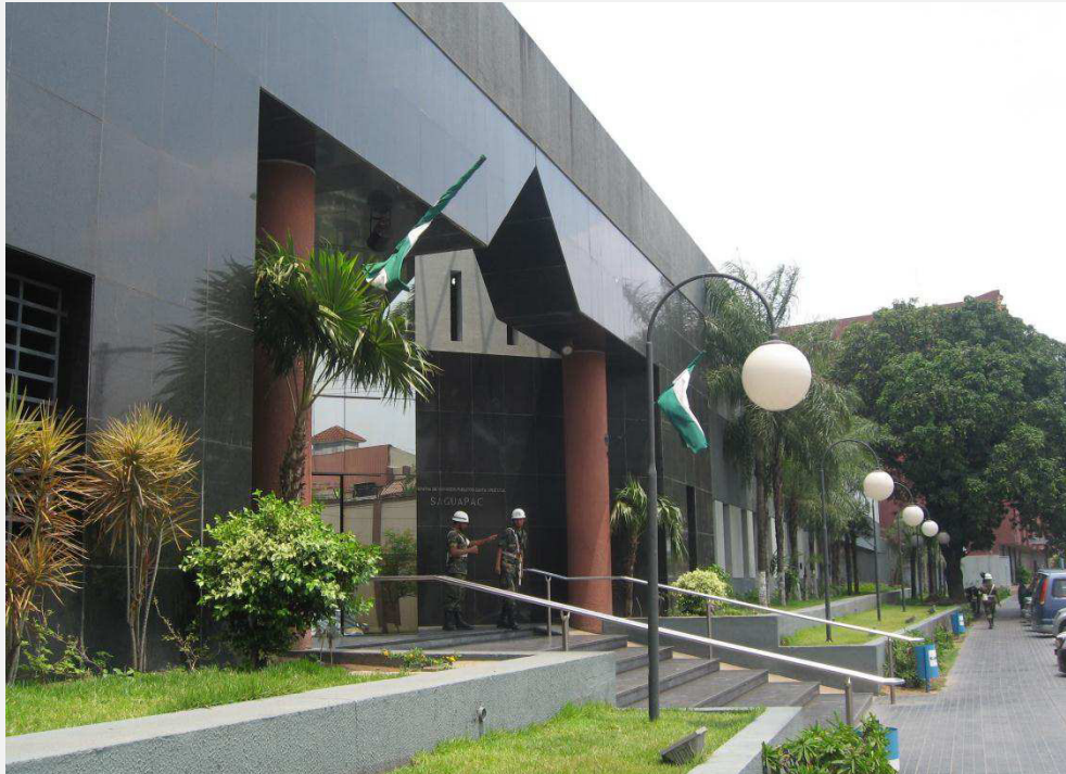
Abbildung 20: Blick auf den Haupteingang der SAGUAPAC-Zentrale
