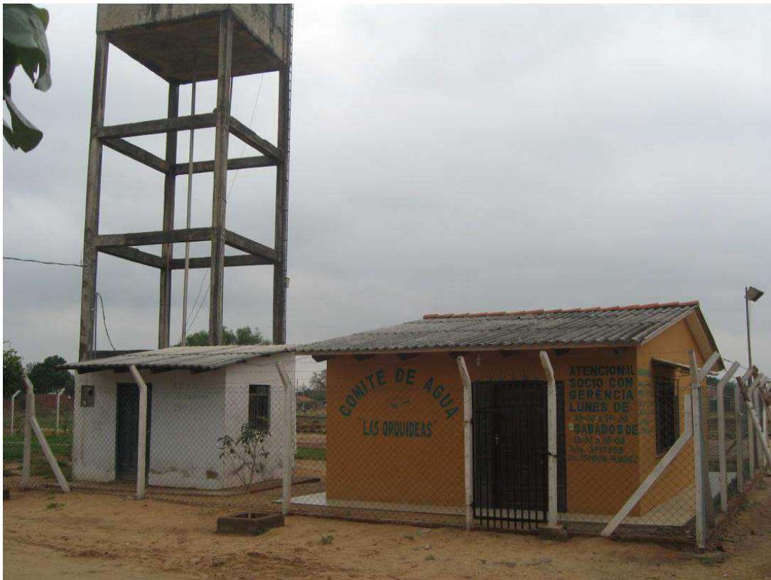
Das Bild zeigt den Hochtank, das Brunnenhäuschen und das Sekretariat des Wasserkomitees Las Orquídeas. (Foto: M. Eichholz, Oktober 2011)
