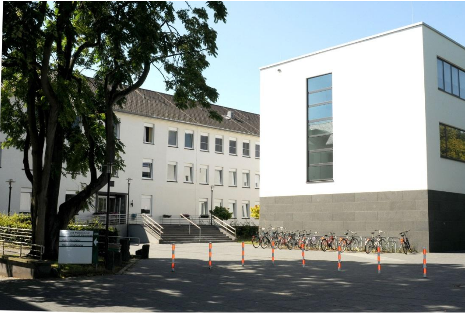
Abbildung 31: Zustand nach Abriss des Hörsaaltraktes und Aufbau des Lehrgebäudes 2008
