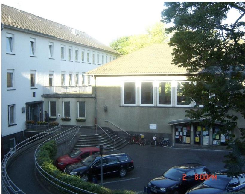
Abbildung 28: Hörsaalgebäude als Anbau an die neue Hautklinik mit Rampe. Aufnahmedatum wahrscheinlich nach 2000.
