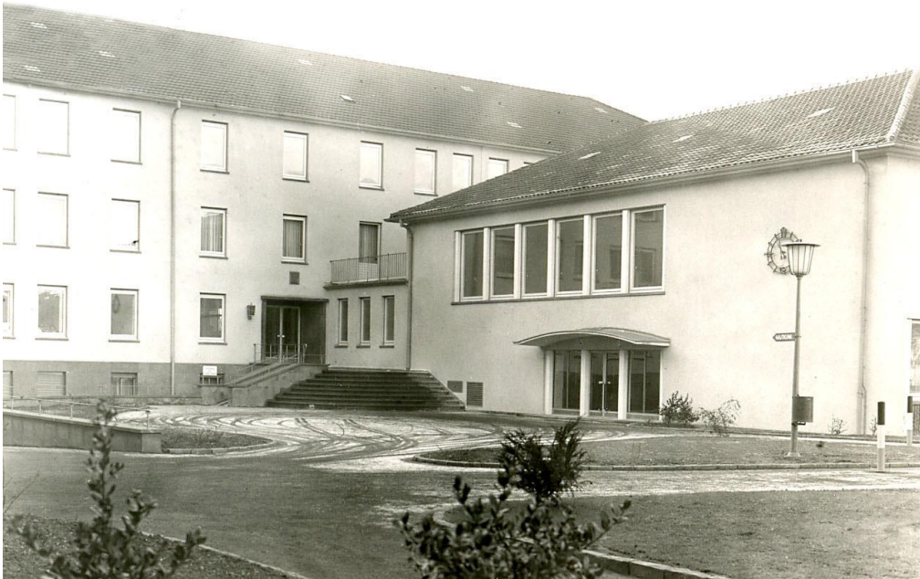
Abbildung 27: Hörsaalgebäude als Anbau an die neue Hautklinik 1956.
