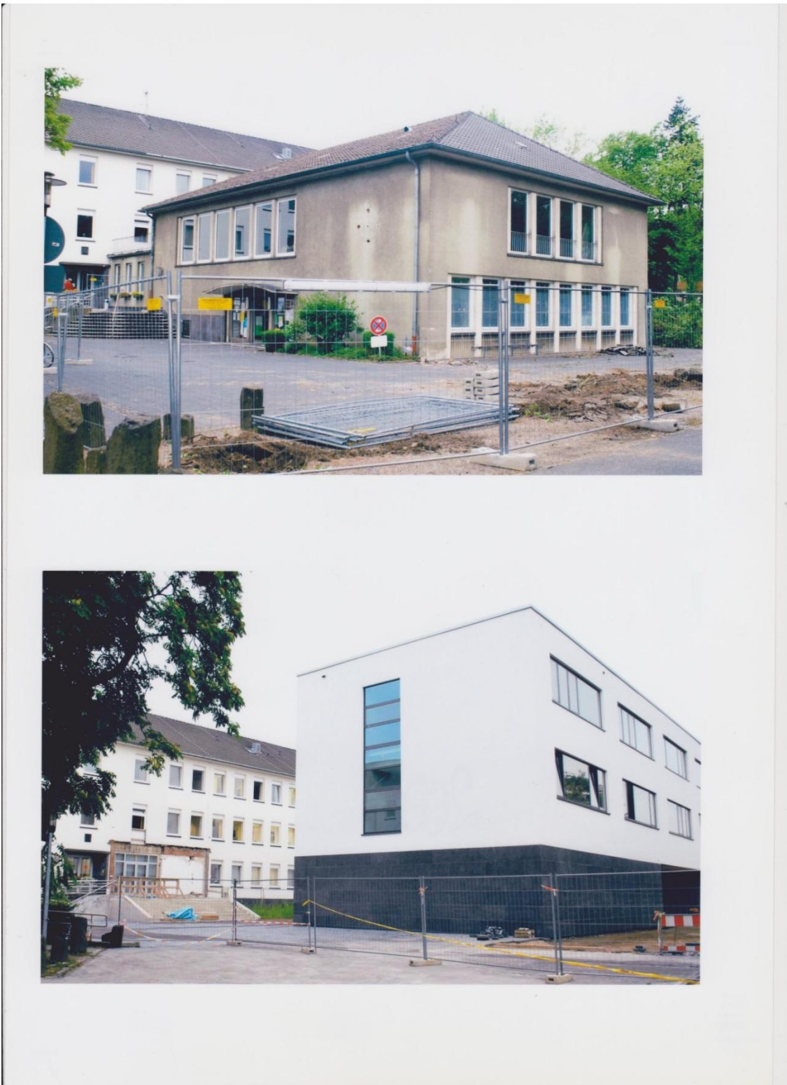
Abbildung 30: Vorher-Nachher Ansicht des Anbaus an die Hautklinik auf dem Venusberg. Die obere Abbildung entstand 2007 die untere Abbildung 2008.
