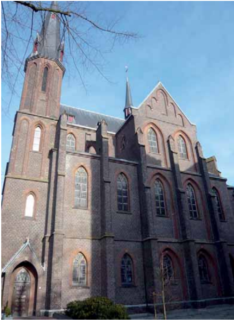
Abb. 11: Südfassade der Engelkirche
