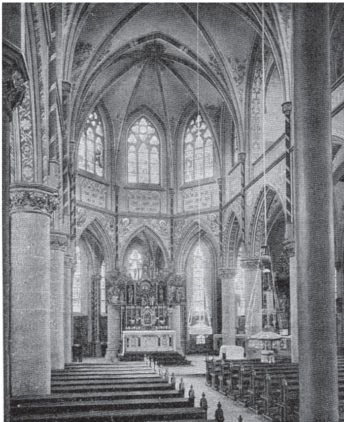
Abb. 17: Oberkirche, Innenansicht des Mittelschiffs (vor der Restaurierung)
