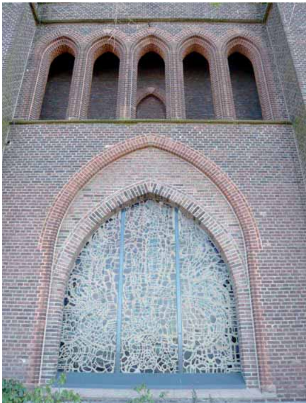
Abb. 12: Westfassade mit Spitzbogenfenster und Loggia darüber
