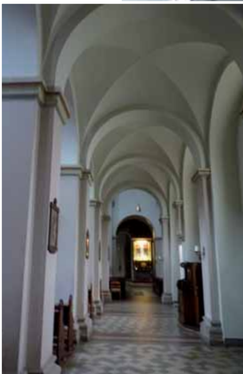
Abb. 98b: Seitenschiff mit Gewölbe
