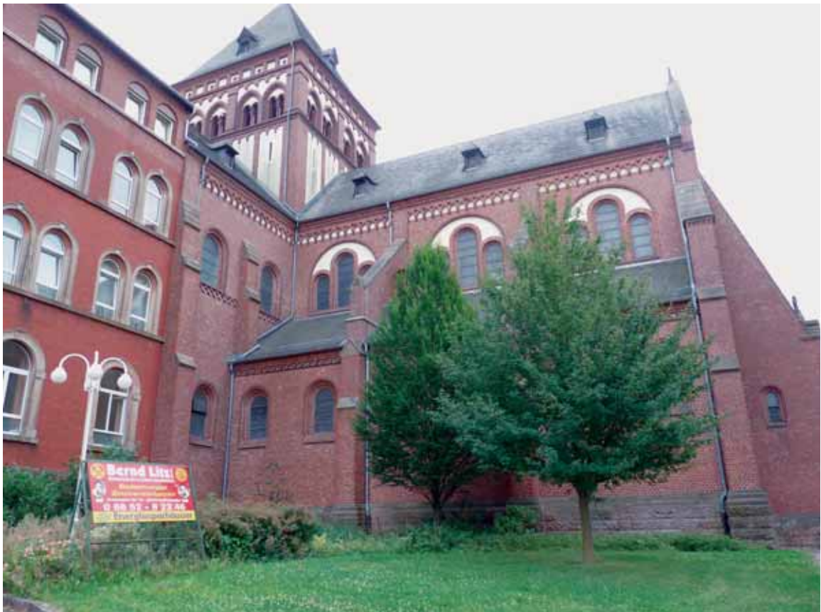
93a. Ansicht Nordseite Kirche, St. Wendel
