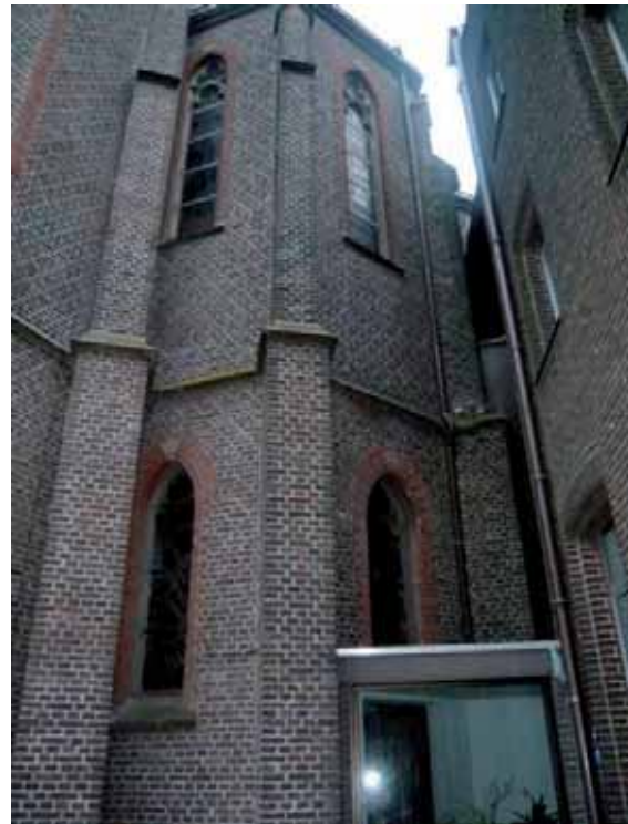
Abb. 10: Verbindung der Engelkirche mit dem Missionshaus im Osten
