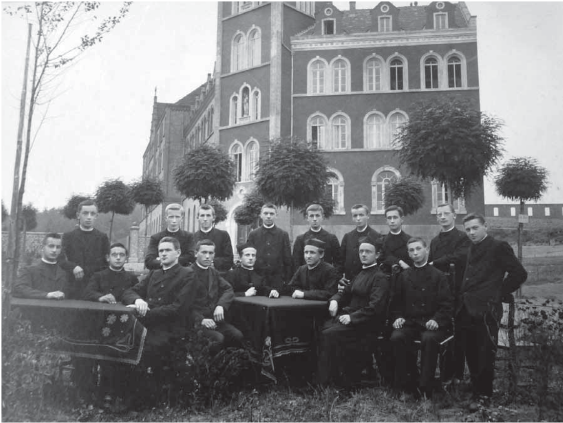
Abb. 79b: Alte Aufnahme des ersten fertiggestellten Gebäudeteils, St. Wendel
