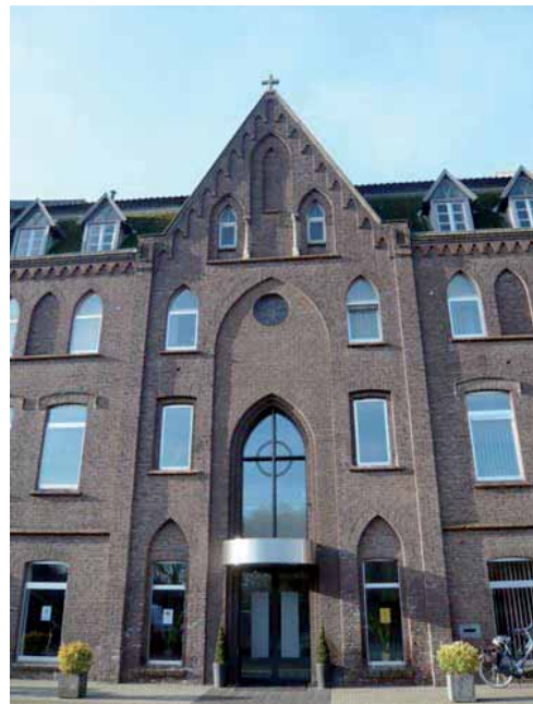
Abb. 5b: Ostfassade, südlicher Giebelbau
