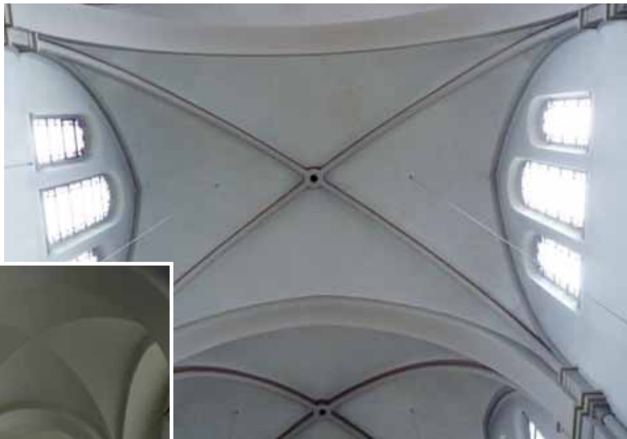
Abb. 98a: Gewölbe Mittelschiff
