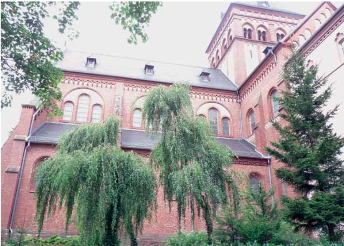
Abb. 93c: Ansicht Süden und Querhaus Kirche, St. Wendel
