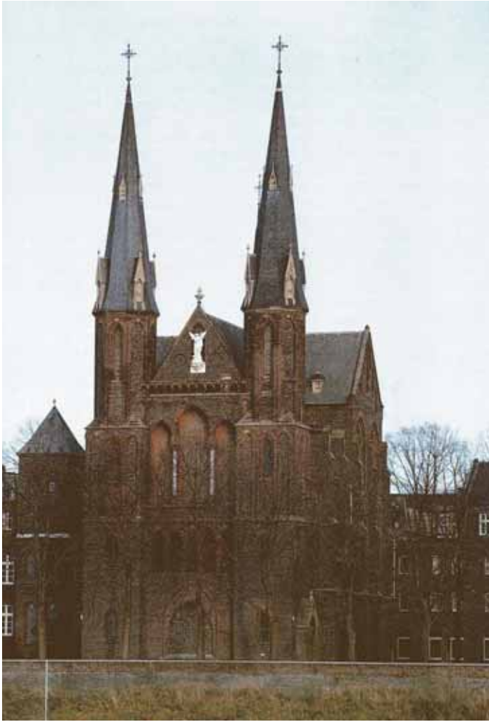
Abb. 13: Westfassade der Engelkirche
