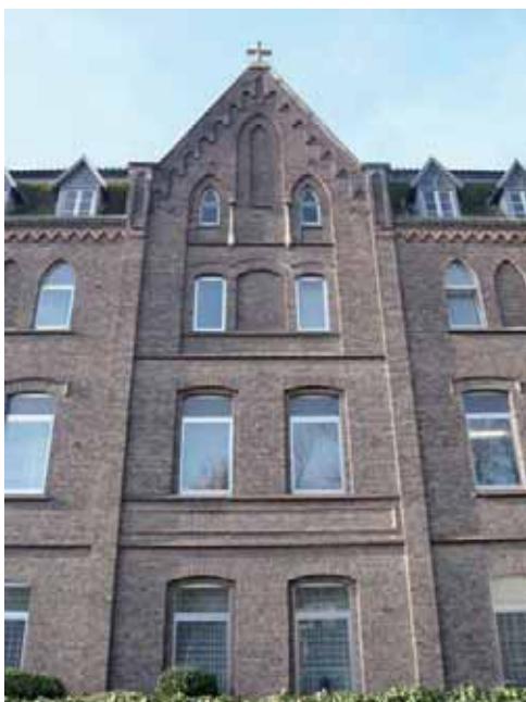
Abb. 5a: Ostfassade, nördlicher Giebelbau
