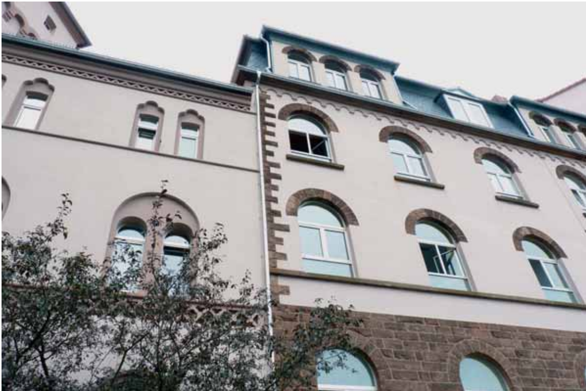
Abb. 83a: Ansicht Südflügel, St. Wendel
