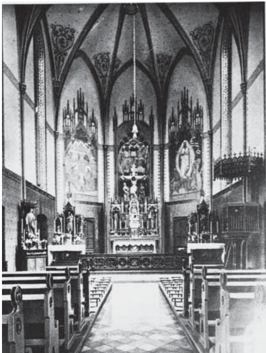
Abb. 150: Blick in das Langhaus der Kirche St. Antonius in Aachen in Richtung Chor
