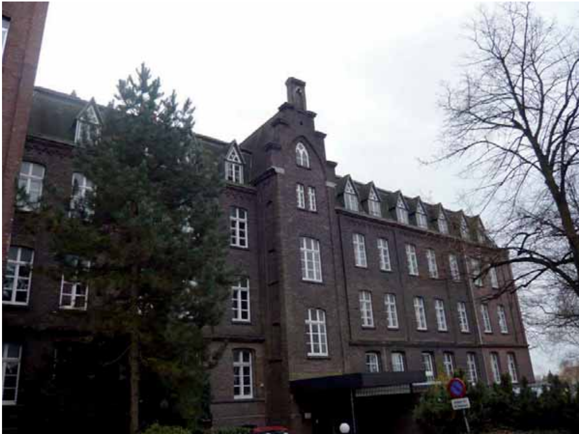
Abb. 8: Fassade Nordseite, Schul- und Küchenbau
