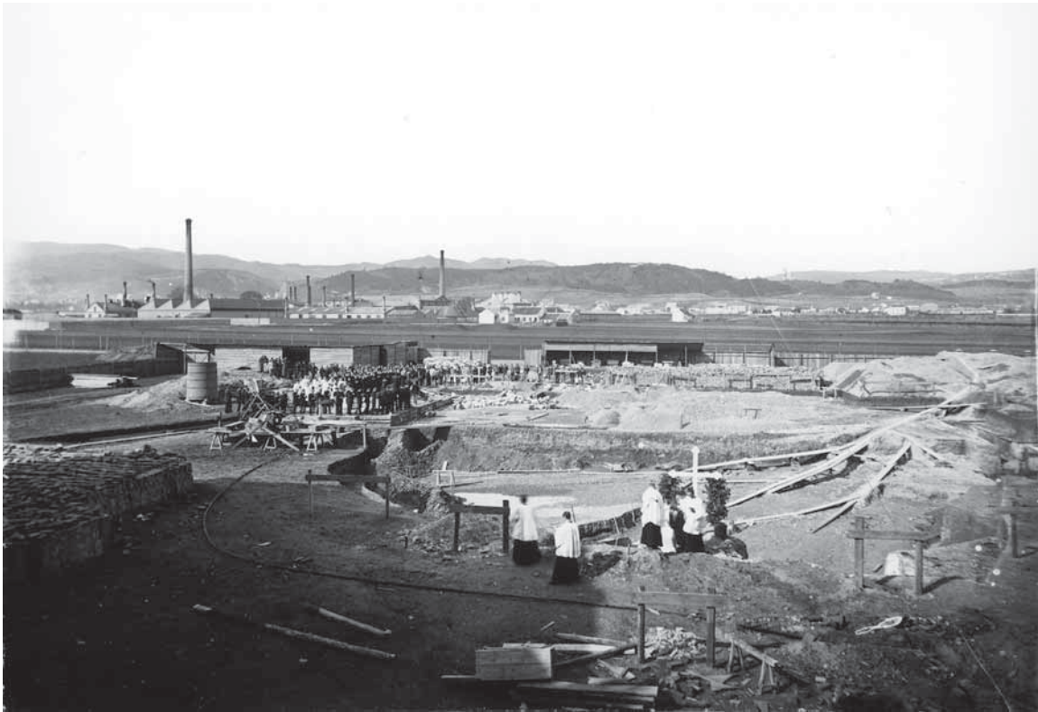
Abb. 42: Baubeginn Kirche, St. Gabriel
