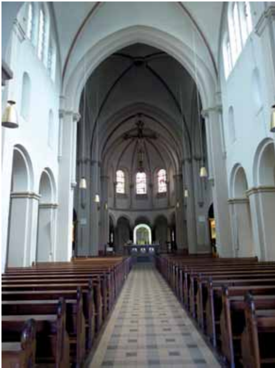
Abb.97: Innenansicht Kirche nach Osten
