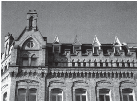
Abb. 128: Detail der Backsteinfassade der Fabrik Stollwerk in Köln
