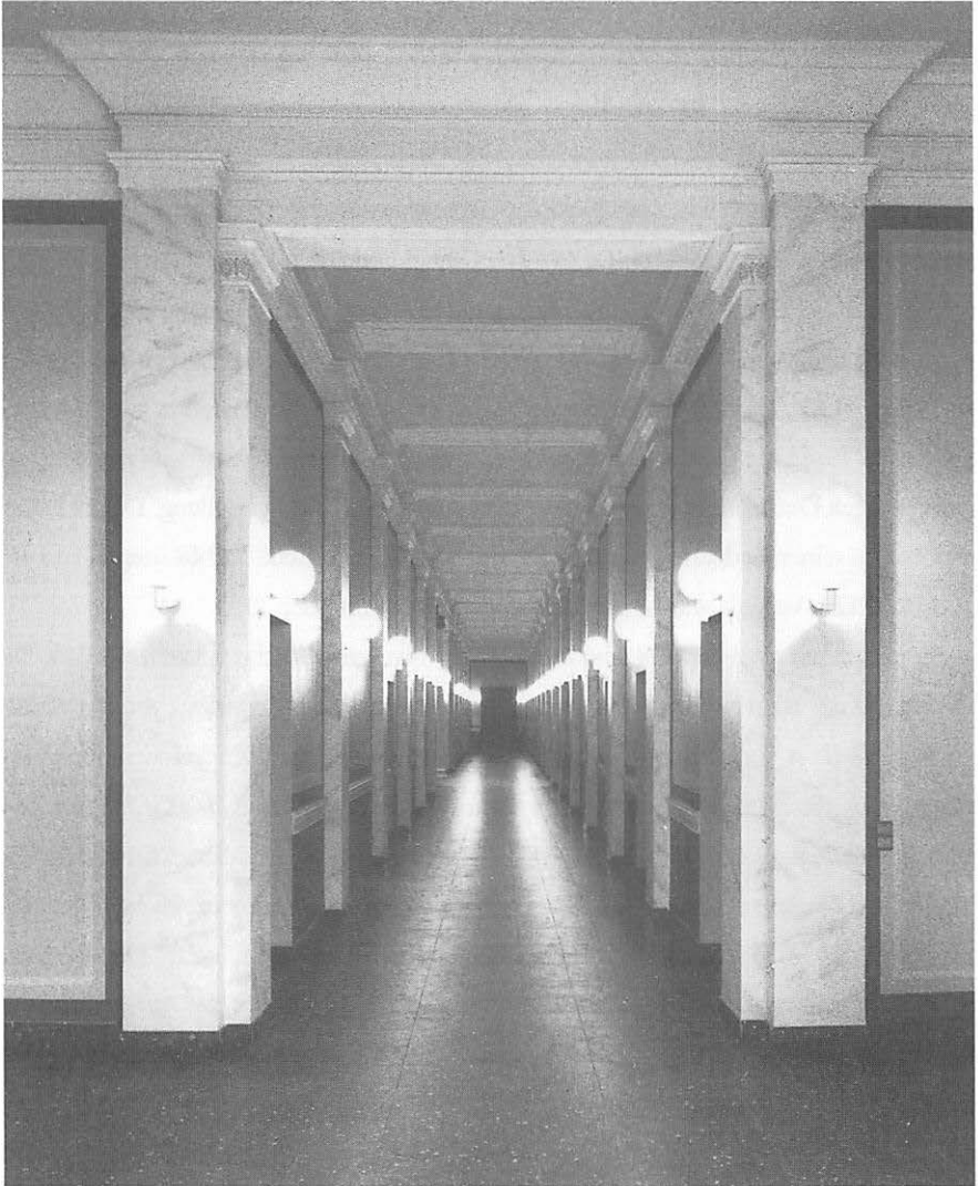
Abb. 20: Ehemaliges Chemisches Institut, heutige Geographische Institute. Blick vom Vestibül in den Hauptkorridor, Zustand nach der Restaurierung 1987.
