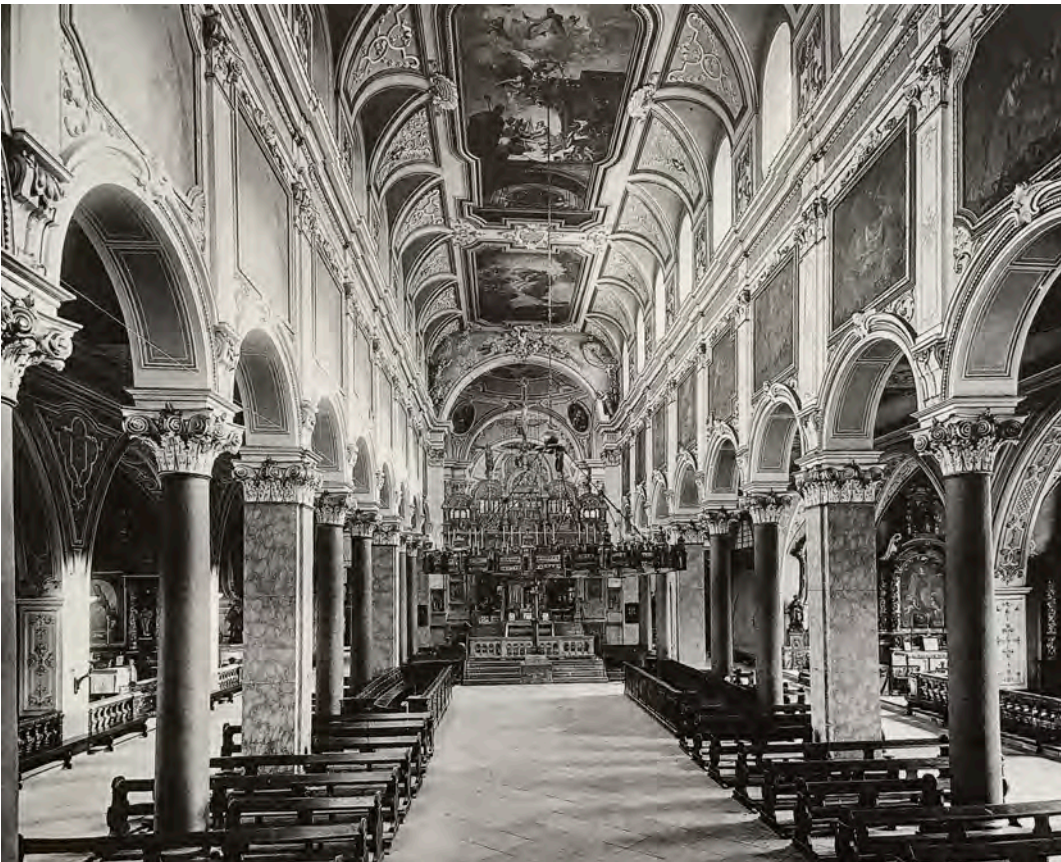
Abb. 22: Heziloleuchter nach der Elektrifizierung.
