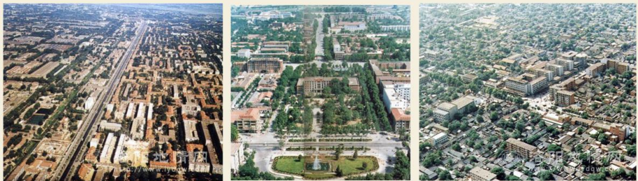
Abb.4-17: Industriebauten im Westen der Stadt (links), der Gebäudekomplex der Innenstadt von Xiagong in den 1980er Jahren (Mitte) und der Gebäudekomplex der Altstadt von Luoyang (rechts) (Quelle: Informationsnetz Luoyang; http://www.lydqw.com ).
