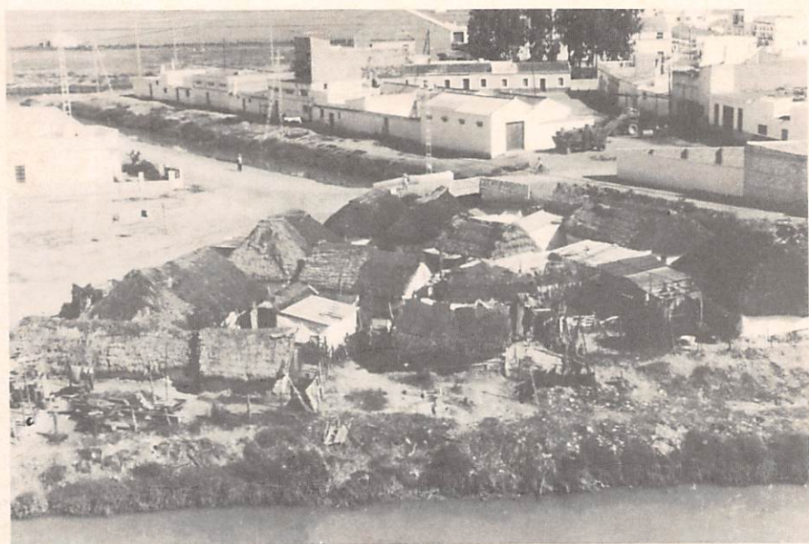
Bild 7 : Villafranco del Guadalquivir (Isla Mayor-Marismas). Haupt- straße mit Reismühle und Papierfabrik
