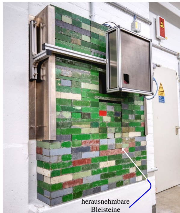
Abbildung 6.7: Foto der Bleimauer vor dem Strahlvernichter. Vor der Mauer ist der Schirm S5 installiert. Um die Verfahreinheit und die Kamera zu schützen, ist eine Schutzhaube um beide gesetzt. Die Bleimauer ist auf den Schwerbetonsockel gesetzt und mit zwei gewinkelten Blechen an der Schwerbetonmauer befestigt. Es ist der unterste rechte Bleistein der herausnehmbaren Bleisteine (3 Spalten \times 8,5 Reihen) markiert.
