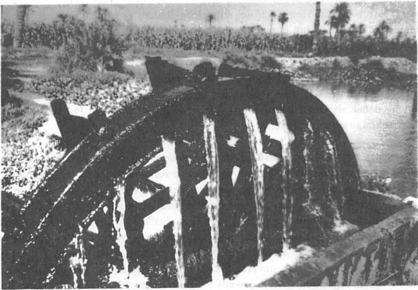
Abbildung 4: Wasserrad ( Nariya ) am Bahr Sinnûris
