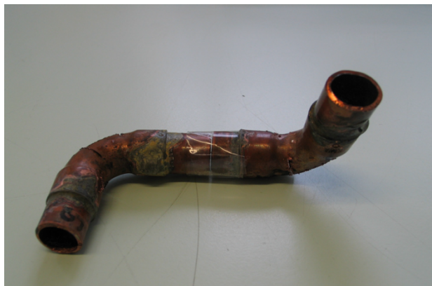
Abb. 11: S-förmiges Rohrstück mit drei von drei positiven Abstrichuntersuchungen
