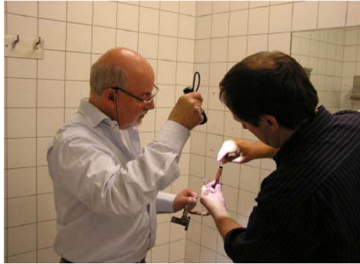
Abb. 9: Externe Experten bei der Entnahme von Abstrichproben des Teilstrangs
