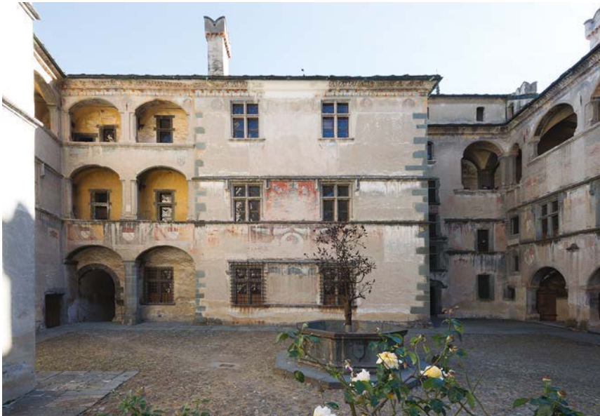
Abb. 2: Issogne, Castello di Issogne, Cortile, Blick nach Osten
