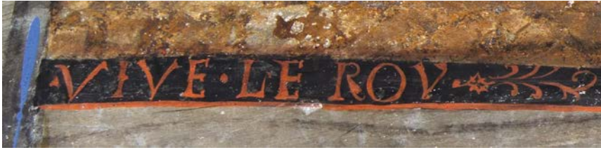
Abb. 15: Issogne, Castello di Issogne, 2. OG, Chambre du Roi , Nordwand, Wandmalerei, 1490er Jahre, Inschrift (Detail)
