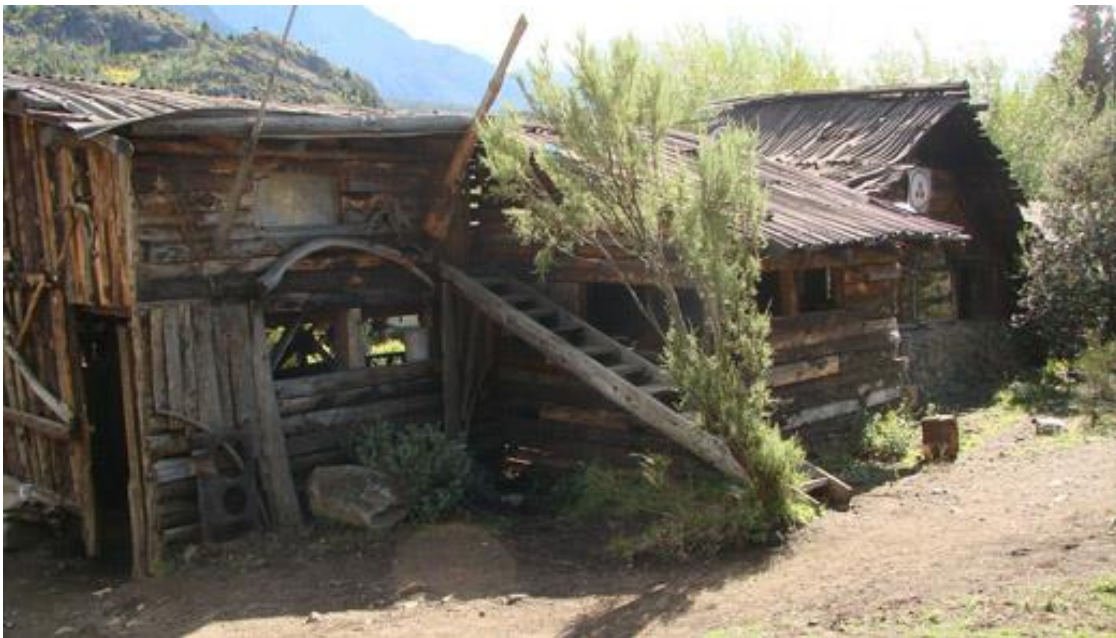
Abbildung 4 Gebäude des CREST 13-Zentrums Epuyen ( http://www.crest13.org/images/centers/epuyen/epuyen02.jpg , letzter Zugriff am 10.01.2021)
