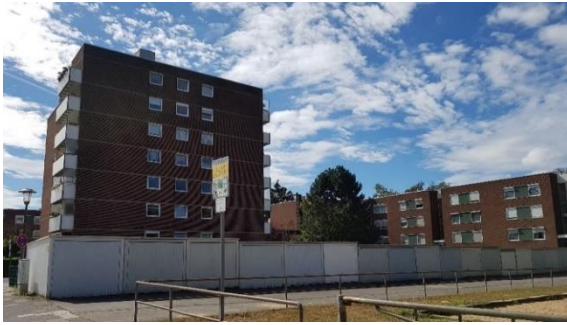
Abbildung 19: Mehrgeschossige Wohngebäude in Köln Pesch (eigenes Foto, 2019)
