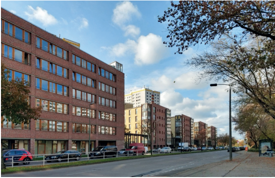
5.3 Abb. 51 Berlin-Marzahn, Verwaltungsgebäude und Wohnbauten entlang der Mehrower Allee, Aufnahme 2019
