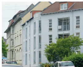
5.3 Abb. 25 Altenessen, Altenwohnungen, Details Außenansicht, Aufnahme 2013
