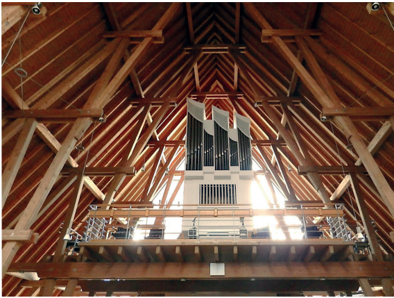
5.6 Abb. 11 Dormagen-Delhoven, Pfarrkirche St. Josef, Detail Holzkonstruktion und Überleitung Wand zum Dach, Aufnahme 2017
