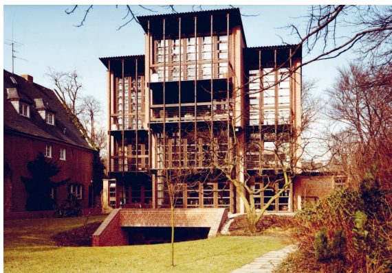
5.3 Abb. 12 Köln, Wohnhaus von Rautenstrauch, Süd- bzw. Gartenansicht, Stahl 3441-2-382, Aufnahme 1982
