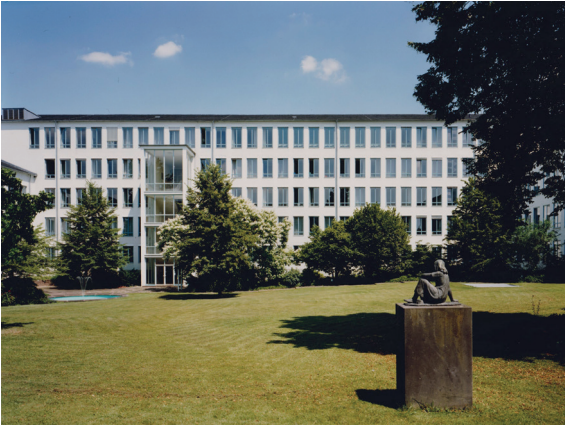
5.5 Abb. 17 Bonn, ehem. Postministerium, Ansicht Hofseite, Claßen, Aufnahme 2000, in: Andreas Denk/ David Kasperek (Hg): Walter von Lom. Einpassung und Eigensinn. Bauten und Entwürfe 1972-2012, Köln 2023, S. 215.
