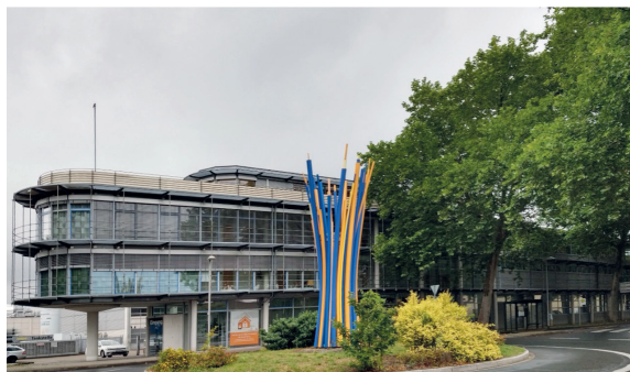
5.5 Abb. 51 Sieburg, Rhenag, Dienstleistungsgebäude Ansicht Süd-Ost, Aufnahme 2020
