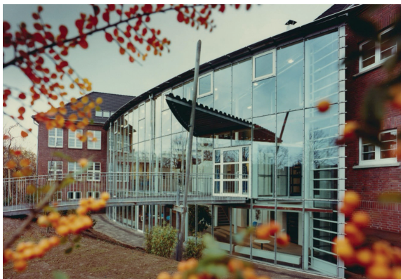
5.4 Abb. 119 Dormagen, Kulturzentrum Glasgalerie, Ansicht von Norden, Stahl 4406-8-1190, Aufnahme 1990
