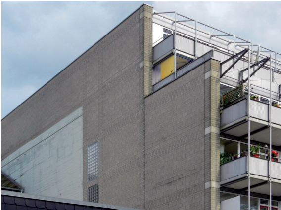
5.3 Abb. 32 Oberhausen, Bunkerüberbauung Detail Baunäht, Aufnahme 2012
