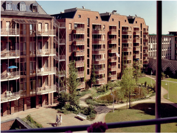
5.2 Abb. 28 Köln, Vincenz-Haus, Rückfassaden Alt- und Neubau, Stahl 3755-6-385, Aufnahme 1985
