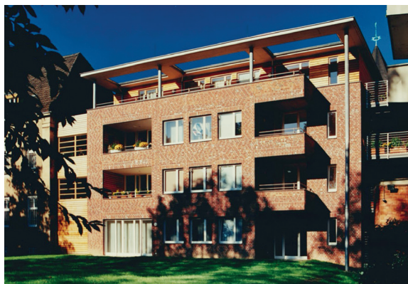
5.3 Abb. 66 Köln, Burgmauer 1a, Rückfassade Stahl 5104-5-1097, Aufnahme 1997
