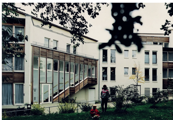
5.2 Abb. 38 Ratingen, Wichernheim, Nordseite Ostflügel, Detail Treppenhhaus, Stahl 4881-6-1094, Aufnahme 1994
