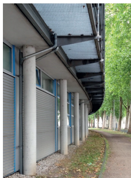
5.5 Abb. 52 Sieburg, Rhenag, Südostfassade mit Blick in das Treppenhaus, Leistner3-1993-di68-Nr-WL1-x-1, Aufnahme 1993/ Fassadenschwung entlang der Wilhelm-Ostwald-Straße, Aufnahme 2020
