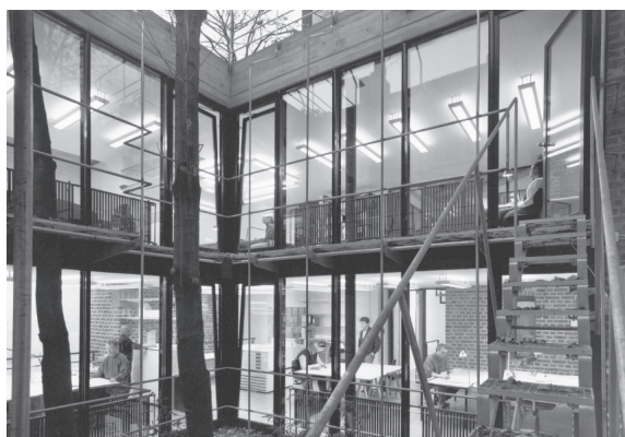
3.1 Abb. 48 Köln, Rhein-gasse 14, Glasfassade zum Innenhof mit Treppenkonstruktion, Stahl 4684-6-1192, Aufnahme 1992
