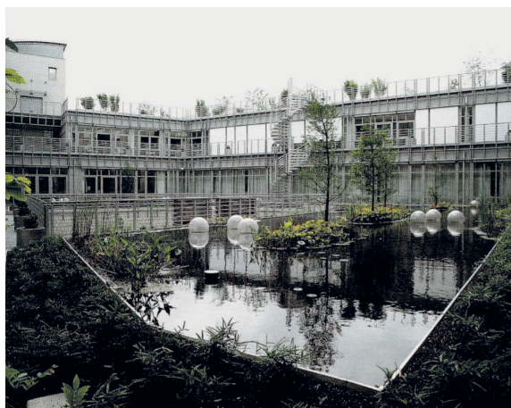
5.5 Abb. 42 Detmold, Sparkasse, begrünter Innenhof mit Wasserfläche, Arbeitsgemeinschaft Baudokumentation 1993, S. 47
