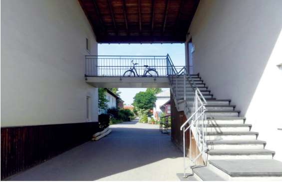
5.2 Abb. 52 Mülheim, Fliedner-Werk, Walter von Lom, Durchfahrt mit Treppenaufgang Bauteil I, Aufnahme 2012
