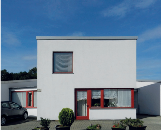
5.2 Abb. 43 Mülheim, Fliedner-Werk, Architekt Peter Kulka, Aufnahme 2020
