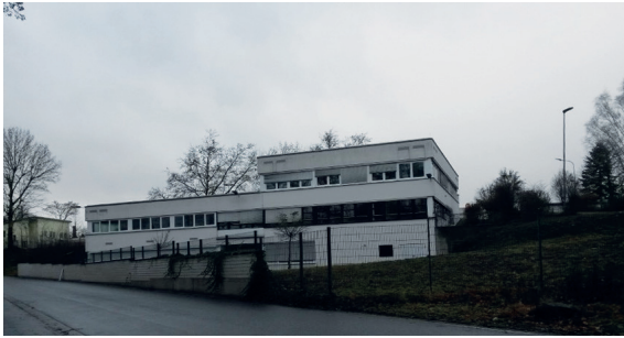
2.4 Abb. 9 Kruft, Sozialgebäude der TUBAG, Ansicht von Süden mit erneuerten Fenstern, Aufnahme 2019
