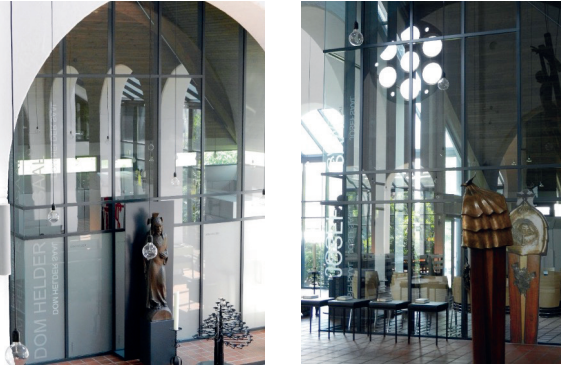
3.4 Abb. 121 Herten-Langenbochum, Marienkirche, Abtrennung der Annexbauten mit Glaswänden (2010), Aufnahme 2013
