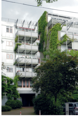
5.3 Abb. 37 Oberhausen, Bunkerüberbauung, Details Fassadenbegrünung Rückseite, Aufnahme 2012
