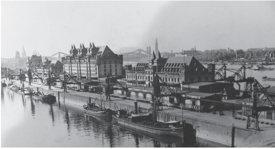
5.4 Abb. 70 Köln, Hafenbecken von Süden, die drei Zollhallen, Architekt Bernhard Below, mit den Dachaufbauten von H. Verbeek, August Sander Aufnahme 1913, Krings 2011 I
