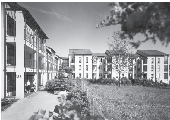
5.3 Abb. 21 Altenessen, Altenwohnungen Ansicht Parkseite, Stahl 3908-3-586, Aufnahme 1986
