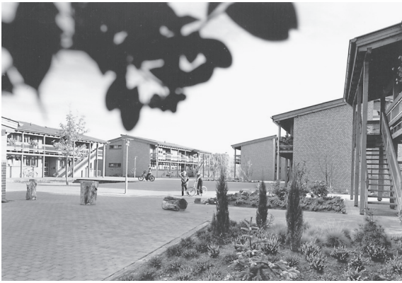
5.1 Abb. 8 Werne, Kinderdorf, Dorfplatz mit umliegenden Wohnhäusern, Lom, Aufnahme 1982
