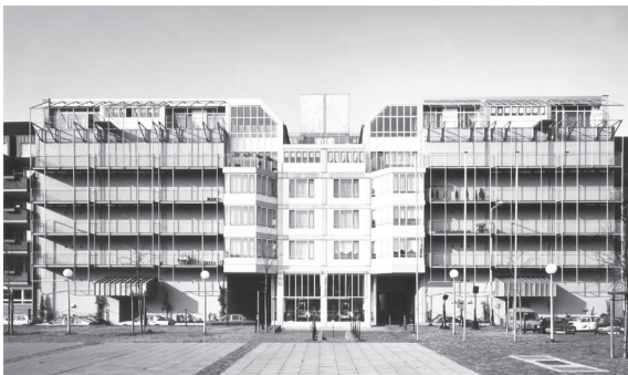
5.3 Abb. 33 Oberhausen, Bunkerüberbauung, An- sicht Südmarkt, Claßen, Aufnahme 1987
