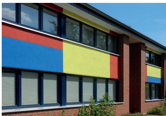
5.1 Abb. 20 Werne, Kinderdorf, Überformung und Erweiterung südöstliches Gebäude, Aufnahme 2012
