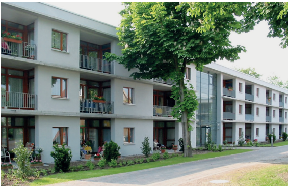
5.6 Abb. 57 Hamm-Heessen, Seniorenwohnanlage „Am roten Läppchen“, Wohnriegel Hospiz-seitig, Aufnahme 2012
