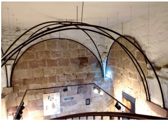
5.4 Abb. 8 Nideggen, Burgmuseum, Detail eingehängte Gewölbeform, Aufnahme 2019
