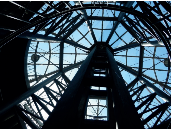
4.2 Abb. 12 Dortmund, Pylon Konstruktion, Blick nach oben, Aufnahme 2013
