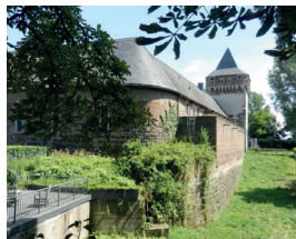
5.4 Abb. 53 Zons, Ansichten historischer Bestand Burg Friedestrom, Aufnahme 2017
