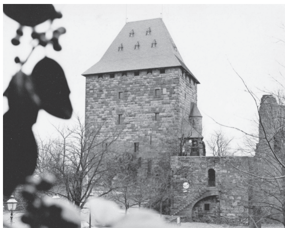
5.4 Abb. 5 Nideggen, Westansicht Bergfried mit Museumseingang, Stahl 3409-7-1181, Aufnahme 1981
