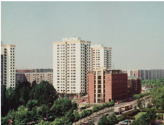
5.3 Abb. 44 Berlin-Marzahn, Verwaltungsgebäude Mehrower Allee 52, Blick auf das Verwaltungsgebäude von Nordost, WBG Marzahn 1982
