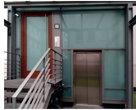
5.3 Abb. 58 Köln, Burgmauer 1, Details Anbau (Aufzug und Treppenhaus), Aufnahme 2020
