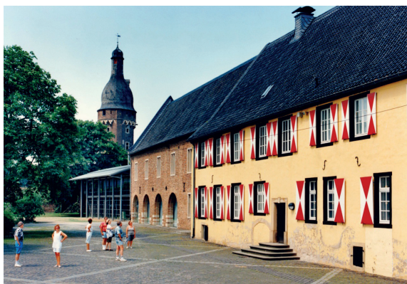
5.4 Abb. 55 Zons, Burg Friedestrom, Gebäude-trilogie mit Herrenhaus, ehem. Pferdestall und Ergänzungsbau, Ansicht von Südwest, Stahl 4852-2-694, Aufnahme 1994
