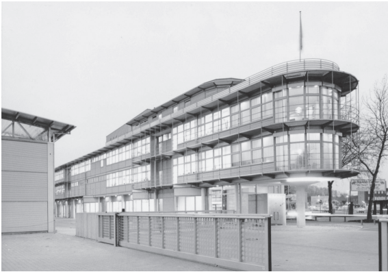
5.5 Abb. 49 Sieburg, Rheingau, Dienstleistungsgebäude Ansicht Süd-West mit Eingangsbereich, Leister3-1993-di68-Nr-WL1-1-1, Aufnahme 1993
