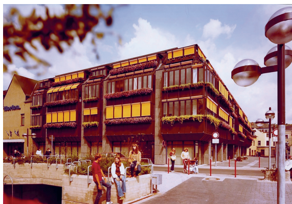
5.5 Abb. 30 Andernach, Rathaus, Ansicht von Norden, Stahl 3259-5-980, Aufnahme 1980
