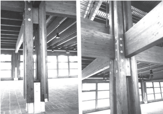
3.2 Abb. 68 Kommern, Ausstellungspavillons, Details Holzkonstruktion, Lom, Aufnahme 1976
