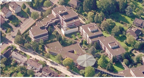
5.6 Abb. 41 Paderborn, Schrägluftansicht Süd St. Vincenz-Altenzentrum/ Haus Maria, Kapellenkubus mittig, Kirche St. Vincenz, 1976, mit oktagonalem Grundriss im Vordergrund, stadtplandienst.de, abgerufen am 16.03.2022
