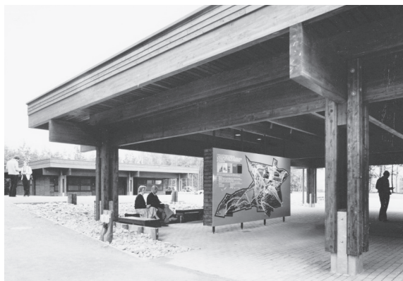
3.2 Abb. 53 Kommern, Freilichtmuseum, offener Eingangspavillon, Stahl 2876-4-977, Aufnahme 1977
