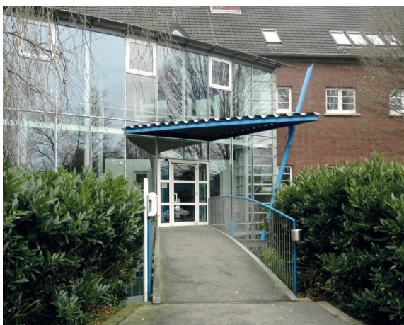
5.4 Abb. 121 Dormagen, Kulturzentrum Fußgängerbrücke zur Glasgalerie, Aufnahme 2017
