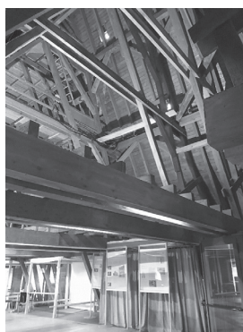
5.4 Abb. 6 Nideggen, Burgmuseum 1. Ausstellungsebene mit ange-deutetem Gewölbe, Stahl 3409-4-1181, Aufnahme 1981/ Ausstellungsbereich im offenen Dachstuhl, Aufnahme 2019
