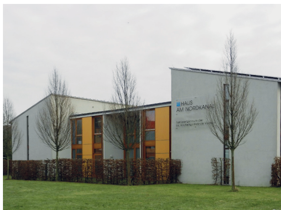
5.2 Abb. 64 Viersen, Seniorenzentrum am Nordkanal, Westfassade, Aufnahme 2012
