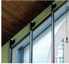
3.4 Abb. 114 Herten-Langenbochum, Marienkirche, Details Annexbau: Fensterband, Holzdecke und Anschluss an Kirchenraum (verändert), Aufnahme 2013
