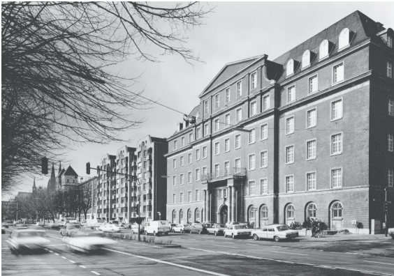
5.2 Abb. 14 Köln, Vincenz-Haus, Fassade rheinseitig, Stahl 3755-1-385, Aufnahme 1985
