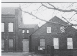
4.2 Abb. 37 Wattenscheid, Pfarrbauten St. Gertrudis vor der Sanierung, Lom, Aufnahmen 1982
