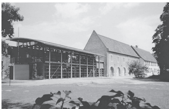
5.4 Abb. 56 Zons, Burg Friedestrom, Gebäude-trilogie mit Ergänzungsbau, ehem. Pferdestall und Herrenhaus, Ansicht von Südost, Stahl 4852-x-694, Aufnahme 1994
