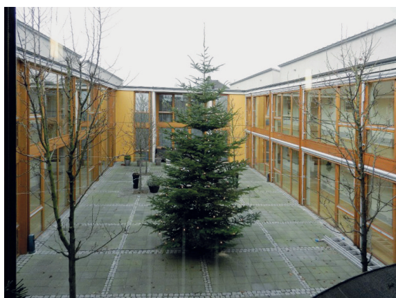
5.2 Abb. 65 Viersen, Seniorenzentrum am Nordkanal, Innenhof, Aufnahme 2012
