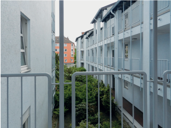
5.3 Abb. 23 Altenessen, Altenwohnungen Ansicht Laubengang, Aufnahme 2013
