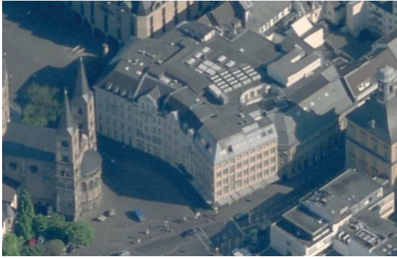
4.2 Abb. 31 Bonn, Mode- und Textilhaus Leffers, Schrägluftbild Martinsplatz/Am Hof, Stadtplandienst.de, abgerufen am 17.07.2022
