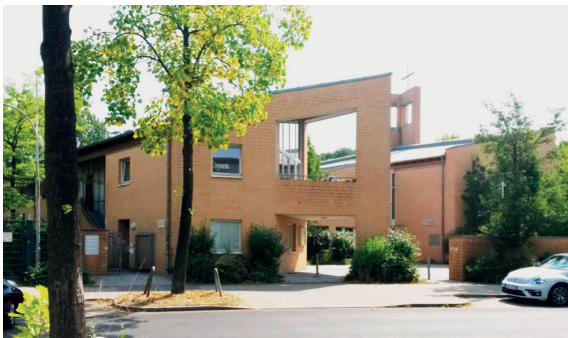
5.6 Abb. 33 Düsseldorf-Hellerhof, Gemeindezentrum, straßenseitige Gebäudekante mit Austritt (OG) und Witterungsschutz (EG), Aufnahme 2018
