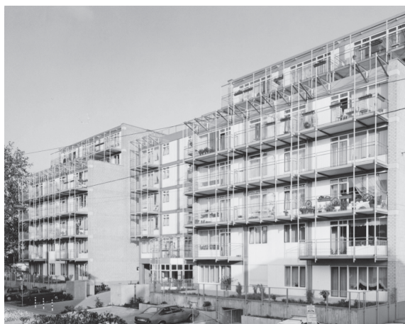
5.3 Abb. 35 Oberhausen, Bunkerüberbauung, Ansicht Styrumer Straße, Claßen, Aufnahme 1987, Andreas Denk/David Kasperek (Hg): Walter von Lom. Einpassung und Eigensinn. Bauten und Entwürfe 1972-2012, Köln 2023, S. 65.
