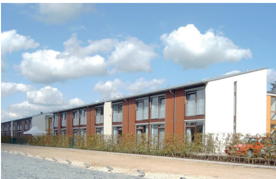
5.2 Abb. 63 Viersen, Seniorenzentrum am Nordkanal, Nord-Ost-Fassade, Lom, Aufnahme 2002
