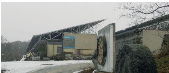
2.4 Abb. 14 Kottenheim, Betriebsgelände der TU-BAG, Nordseite Steinmetzwerkstatt, Aufnahme 2019
