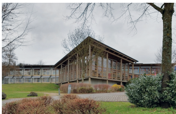
5.4 Abb. 101 Schmallenberg, Informationszentrum für Holz und Touristik, Detail Holzkonstruktion außen, Aufnahme 2019
