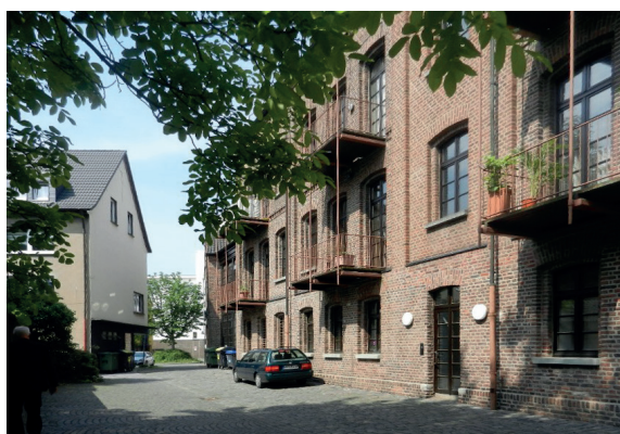
4.2 Abb. 43 Wattenscheid, straßenseitige Ansicht Pfarrbauten, Fassade Untergeschoss, Aufnahme 2016
