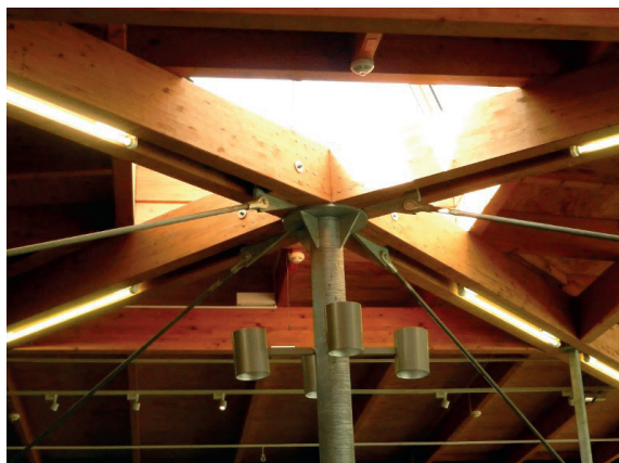
3.2 Abb. 75 Kommern, Freilichtmuseum, Handwerkerhaus Henkel, Innenansicht Oberlicht und Holzkonstruktion, Aufnahme 2015
