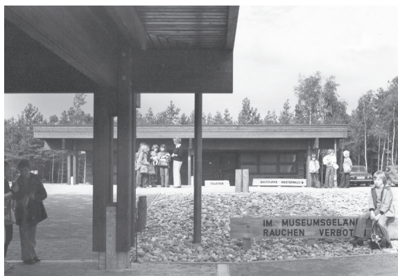
3.2 Abb. 54 Kommern, Freilichtmuseum, Eingangsbereich, Stahl 2876-3-977, Aufnahme 1977
