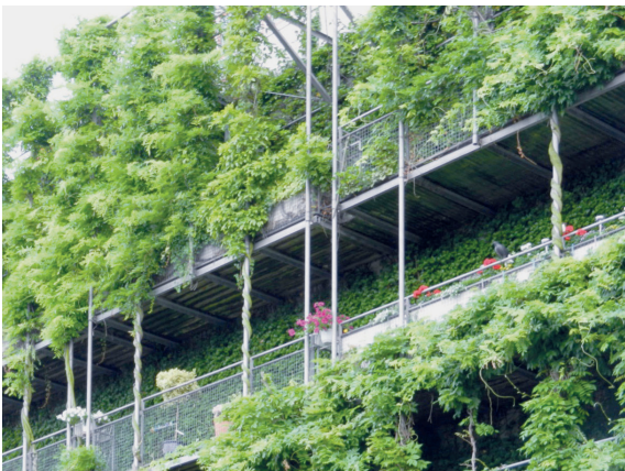
5.3 Abb. 39 Oberhausen, Bunkerüberbauung, Detail Fassade Südmarkt, Fassadenbegrünung, Aufnahme 2012
