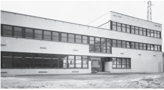
2.4 Abb. 8 Kruft, Sozialgebäude der TUBAG, Ansicht von Süden, Lom, Aufnahme 1972
