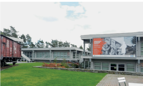
3.2 Abb. 59 Kommerl, Freilichtmuseum, Ausstellungspavillons und Platzanlage, Aufnahme 2015
