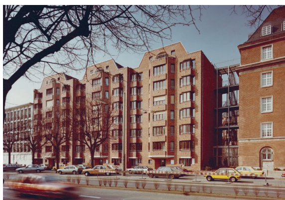
5.2 Abb. 22 Köln, Vincenz-Haus, Straßenansicht Neubau, Stahl 3755-2-385, Aufnahme 1985
