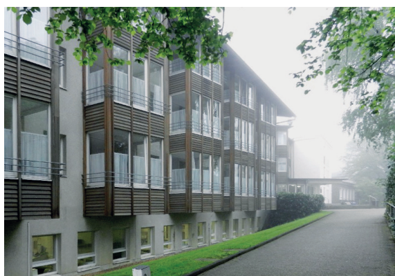
5.2 Abb. 37 Ratingen, Wichernheim, West-Fassade mit Übergang zum Pfarrheim, Aufnahme 2013
