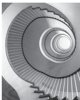
5.5 Abb. 16 Bonn, ehem. Postministerium, umgenutzter Ausstellungsraum des ehem. Briefmarkenmuseums und Haupttreppenhaus, Claßen ID 02603 u. 0260x, Aufnahme 2000
