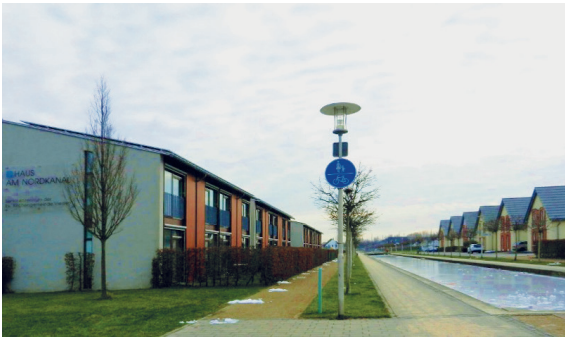
5.2 Abb. 62 Viersen, Seniorenzentrum am Nordkanal, Süd-West-Fassade mit Kanal und gegenüberliegender Bebauung, Aufnahme 2012
