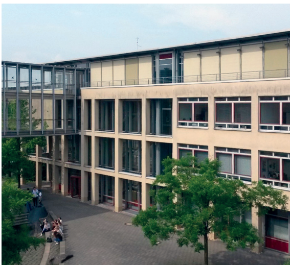
5.5 Abb. 73 Bochum, EZB-Campus, Verwaltungsgebäude Ansicht hofseitig mit Brücke zum Berufskolleg, Aufnahme 2016
