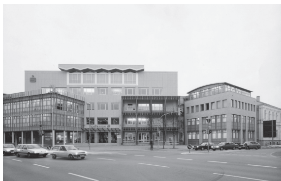
5.5 Abb. 32 Detmold, Sparkasse, Baukomplex Ansicht Nord-Ost, Leistner WL4-16-0, Aufnahme 1994
