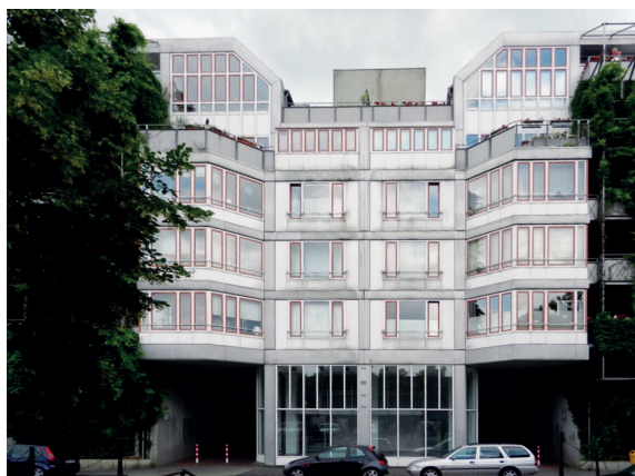
5.3 Abb. 34 Oberhausen, Bunkerüberbauung mittlere Achsen mit Eingangsbereich zum Südmarkt, Aufnahme 2012
