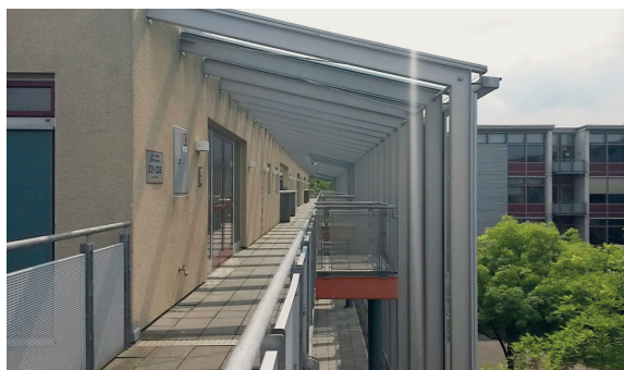
5.5 Abb. 62 Bochum, EZB-Campus, Gästehaus Laufgang und Überdachung 3. OG, Aufnahme 2016
