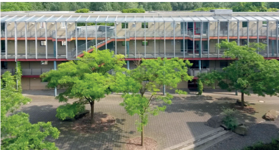
5.5 Abb. 61 Bochum, EZB-Campus, Gästehaus Nordansicht, Aufnahme 2016
