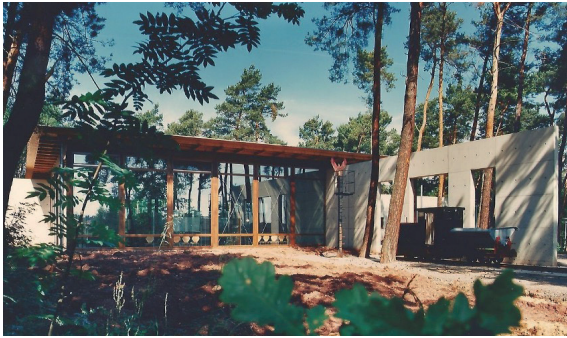
5.4 Abb. 109 Mechernich, Bergbaumuseum Ansicht von Südost, Stahl 4928-x-695, Aufnahme 1995
