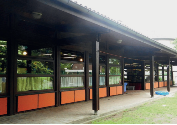
5.1 Abb. 52 Ahlen, Kindergarten St. Gottfried, Ostansicht mit veränderter Farbgebung, Aufnahme 2016
