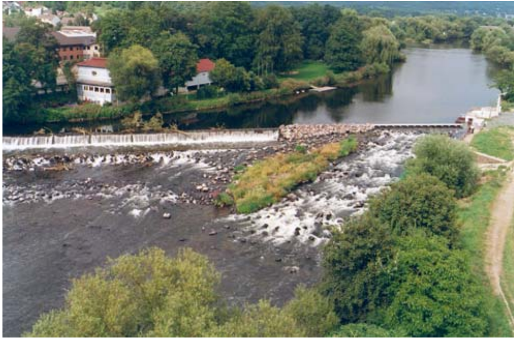
Bild 5. Wehranlage St. Augustin-Buisdorf mit der Fischaufstiegsrampe und der Kontroll- und Fangstation für Fische (auf dem Foto rechts, oberhalb der Rampe im OW) (Foto: E. Städtler)
