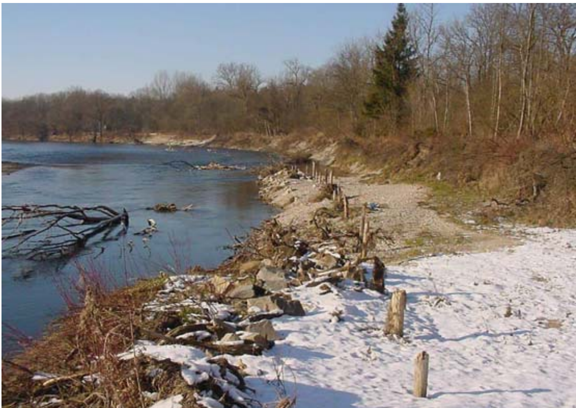
Abb.6: Nach Entnahme der Ufersicherung begann das Gewässer bei Hochwasser seine Ufer eigendynamisch zu gestalten
