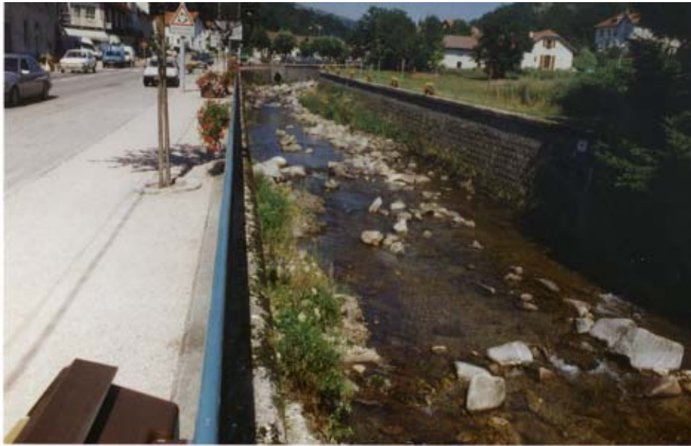
Bild 6. Ökologische Aufwertung eines Fließgewässers? Zwangspunkte sind der Hochwasserschutz und die Nutzung der gewässernahen Bereiche als Verkehrsflächen (Foto: H. Patt)
