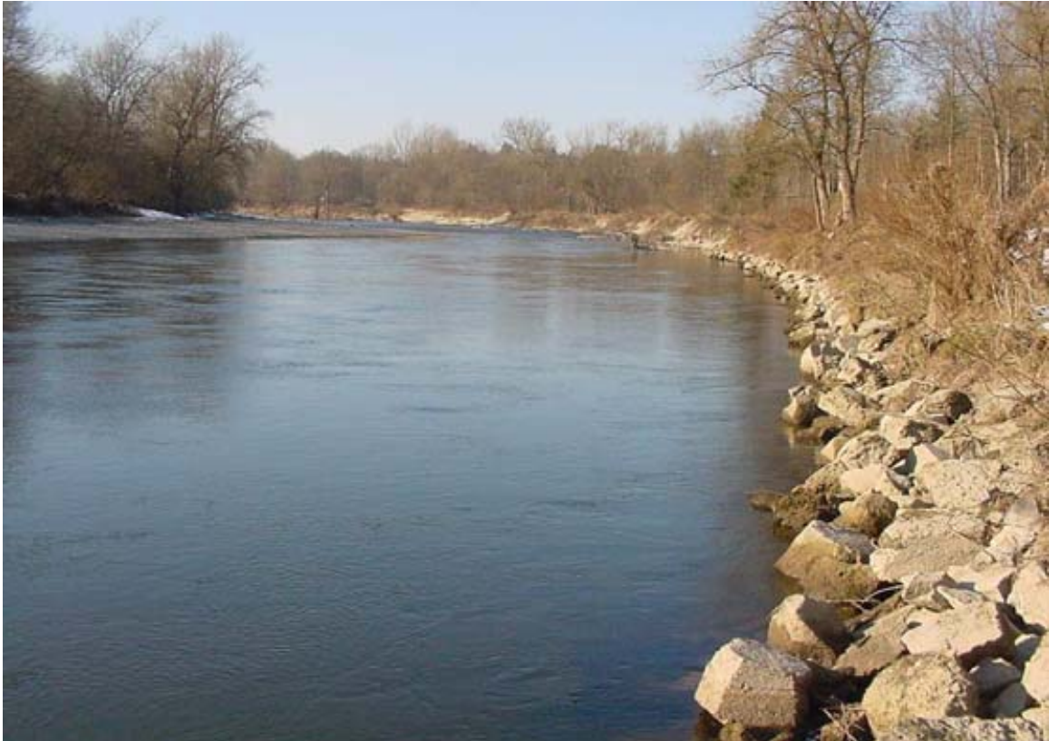
Abb.5: Durch die Befestigung der Ufer mit Wasserbausteinen wurde eine dynamische Fließgewässerentwicklung verhindert (Isar nördlich Moosburg)
