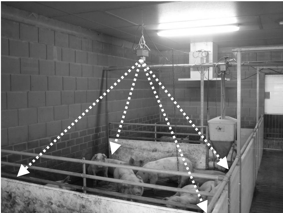
Abbildung 47: Messanordnung der Aktivitätssensoren und abgetasteter Bereich
