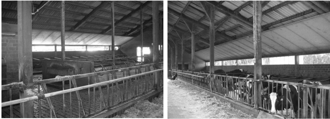
Abbildung 30: Lüftungseinstellung Sommer links und rechts des Futtertisches, Stall Rind_TF
