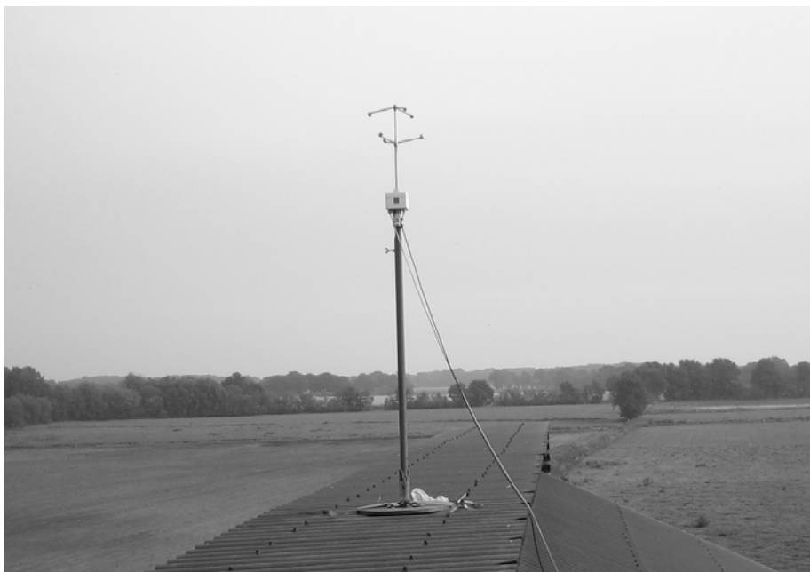
Abbildung 44: Ultraschallanemometer auf dem First des Liegeboxenstalls
