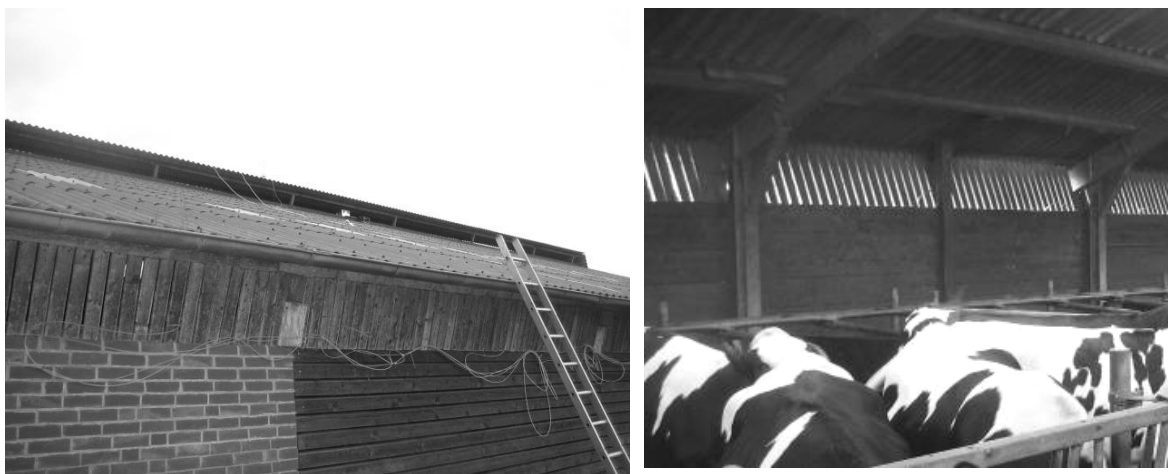
Abbildung 31: Firstöffnung und Zuluftsystem im Stall Rind_SB
