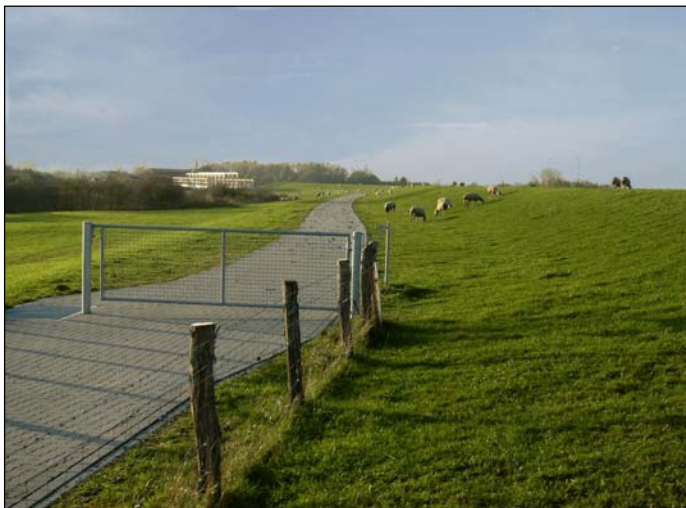
Abbildung 7: Deich Bislicher Insel nach der Fertigstellung
