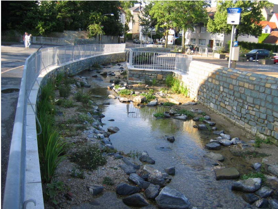
Abbildung 4: Freigelegter Bachlauf im Stadtgebiet
