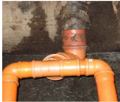
Abb. 14: Unterflurabsaugung durch eine FM-Entnahmestelle im Versuchsabteil
