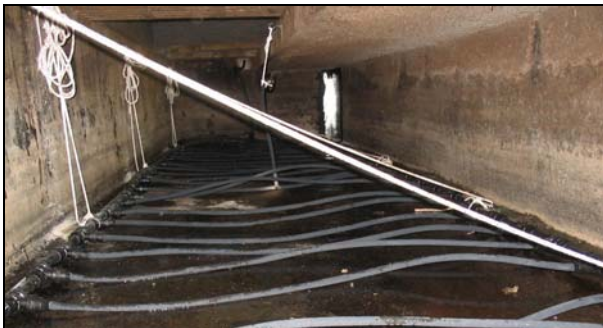
Abb.12: Installation der Belüftungsgitter im FM-Kanal des Versuchsabteils
