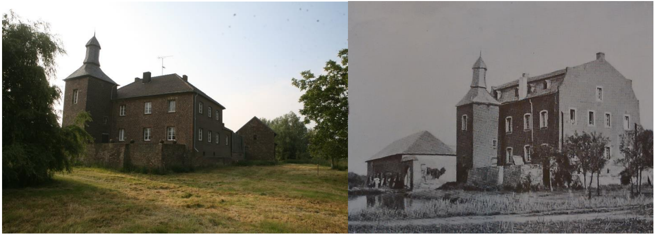
Abb. 41. – Haus Pesch kurz vor dem Abriss.
