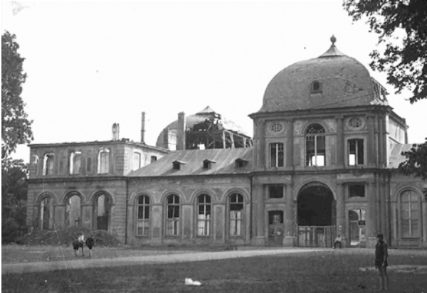
Abb. 66: Die weitgehend erhalten gebliebene (nordöstliche) Frontseite des kriegszerstörten Poppelsdorfer Schlosses mit ausgebranntem Dachstuhl des Botanischen Institutes (links); beim Wiederaufbau des Schlosses Anfang der 1950er Jahre wurde das Obergeschoss durchgängig angelegt sowie ein Zwischengeschoss eingezogen [Foto ca.1946 Autor unbekannt , Archiv des Poppelsdorfer Heimatmuseum]
