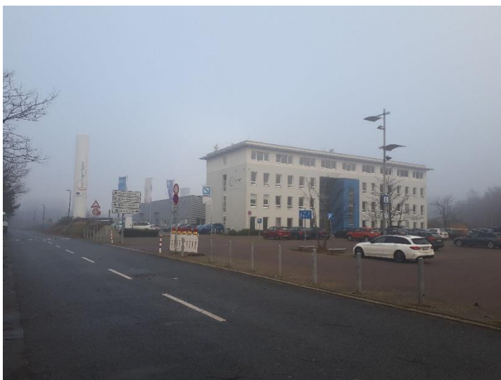
Abbildung 8: Anwenderzentrum der Stadt Herten auf einem ehemaligen Zechengelände (eigene Aufnahme, 5.11.2021)
