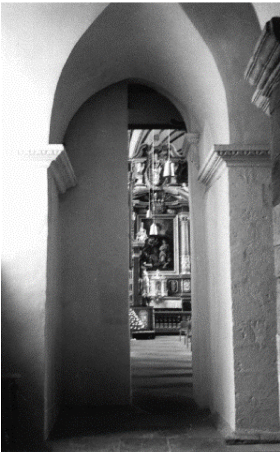
Abb. 26: Ansicht des westlichen Wandpfeilers von Nordwesten. Übergang vom Westbau zum barocken Langhaus. Aufnahme: Johlen 1995.
