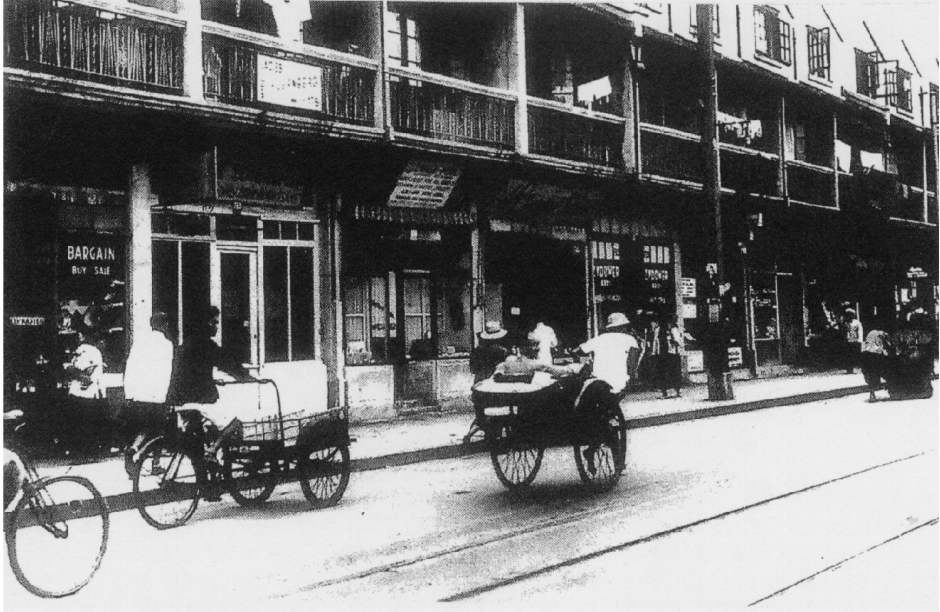
Abb. 8 Seward Road im Shanghaier Stadtteil HONGKEW; 1940
