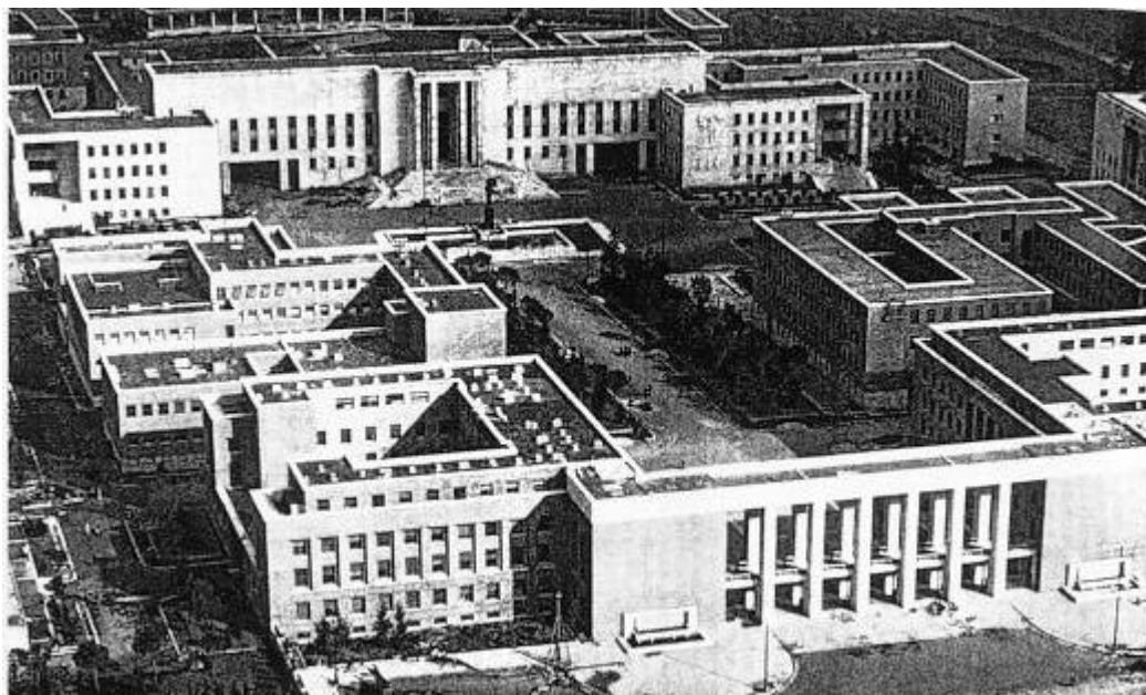
Abb. VIII/31 Marcello Piacentini, Universitätsgebäude in Rom (1932-35)
