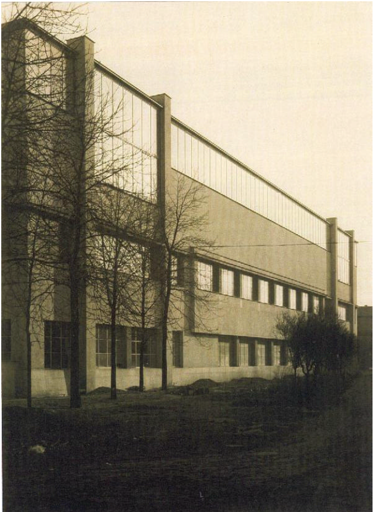
Abb. V/44 Rückwärtiger Querbau, Zinzendorfstraße
