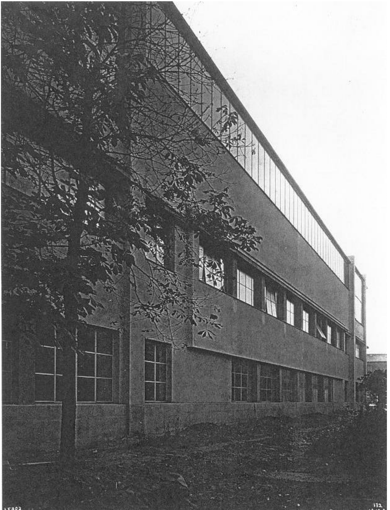
Abb. V/45 Rückwärtiger Querbau, Zinzendorfstraße
