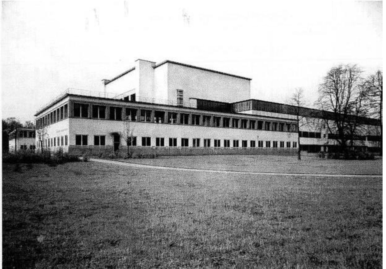
Abb. V/35 Nördliche Seitenansicht, Fassade des nördlichen (rechten) Kopfbaus
