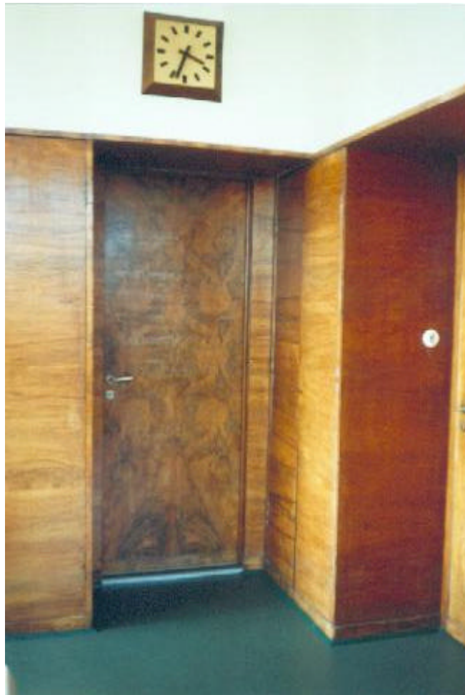
Abb. VI/25 Direktorenzimmer (Foto 1990er Jahre) Verbindungstür zum Vorzimmer/Flurtür
