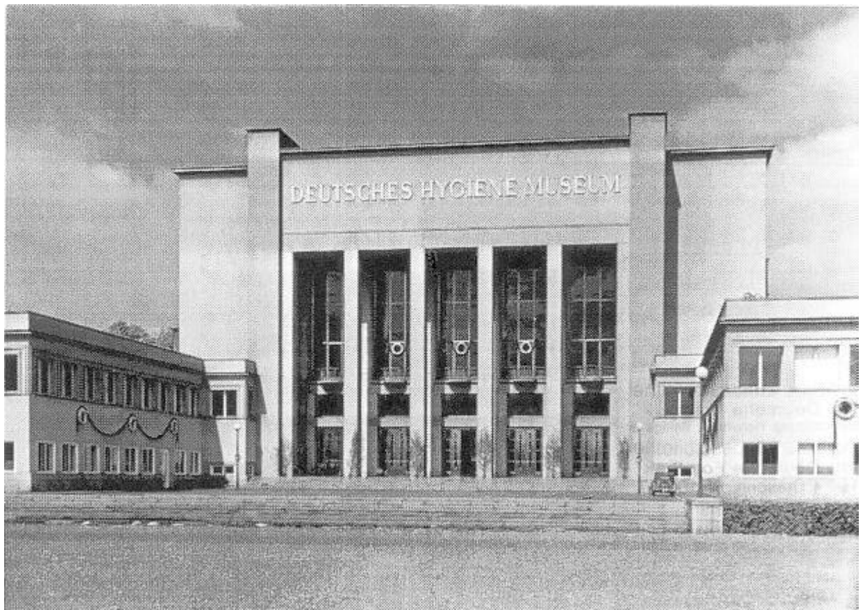
Abb. V/13 Hauptfassade mit Inschrift (1930er Jahre)
