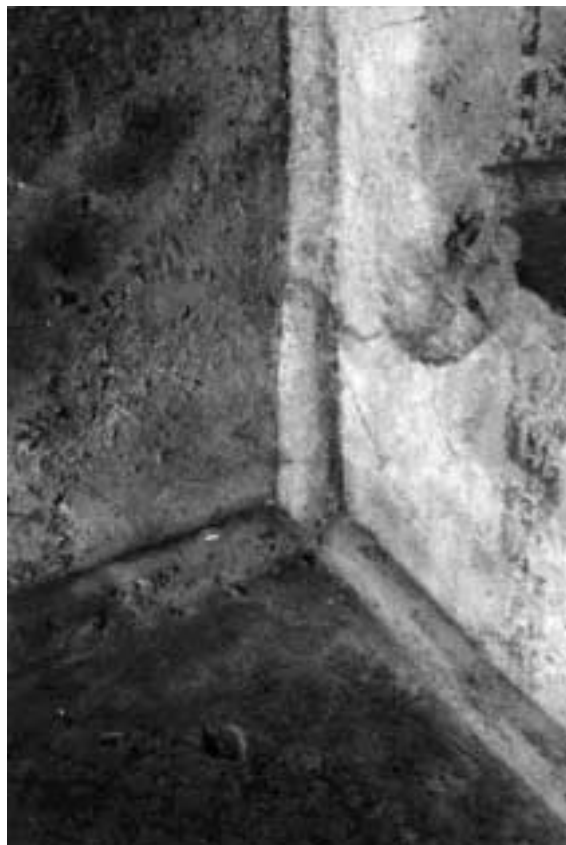
Abb. 41. Ecke in der Piscina W3 mit Dichtungswülsten
