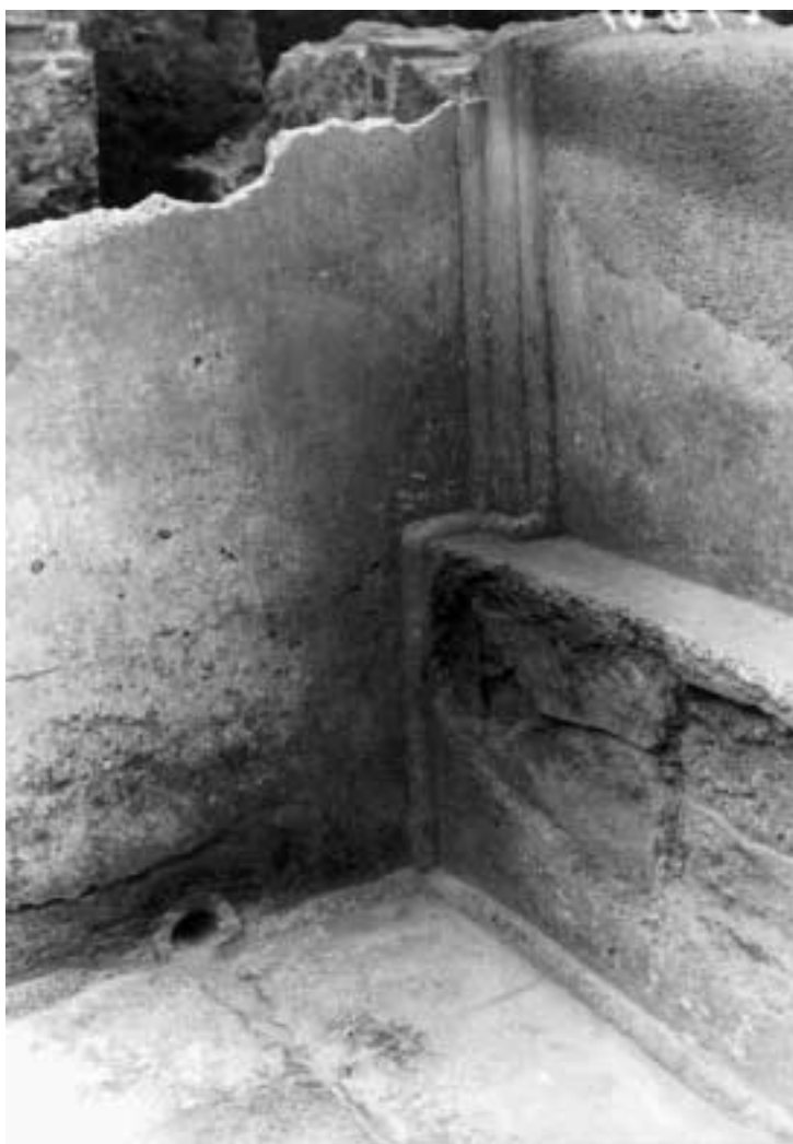
Abb. 44. Nordwestecke der Piscina W4 (von Südosten)
