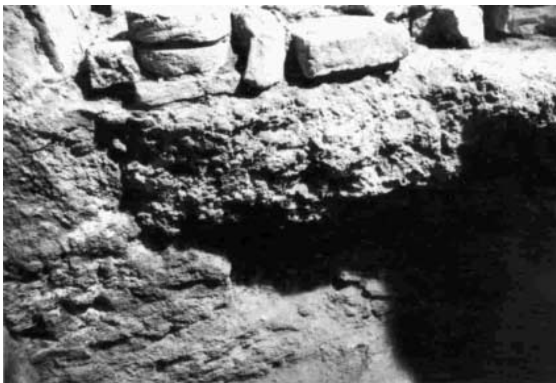
Abb. 5. ausgebrochene Kante der Westmauer des Caldarium im Bereich des Hypokaustbodens des Alveus W2
