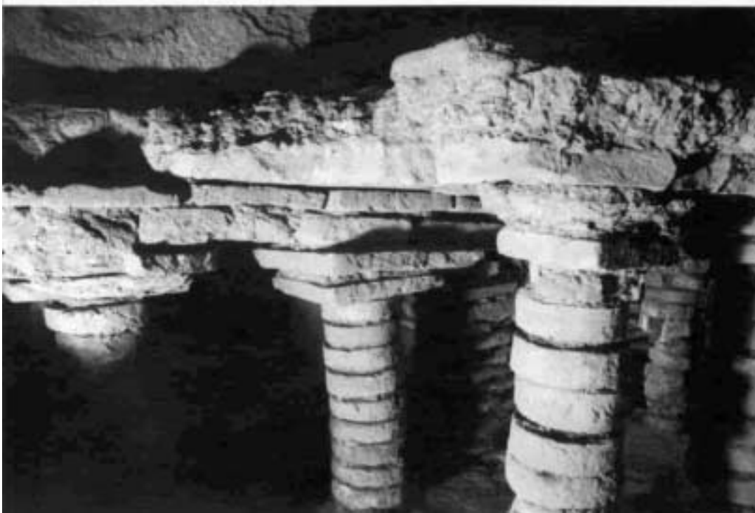
Abb. 9. Suspensurae unter der Brüstung nach W1 mit Absatz
