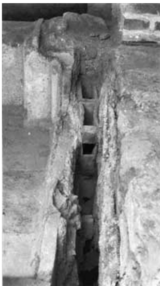
Abb. 23. Hohlwand an der Südmauer des W2 Alveus W2 (von Westen)
