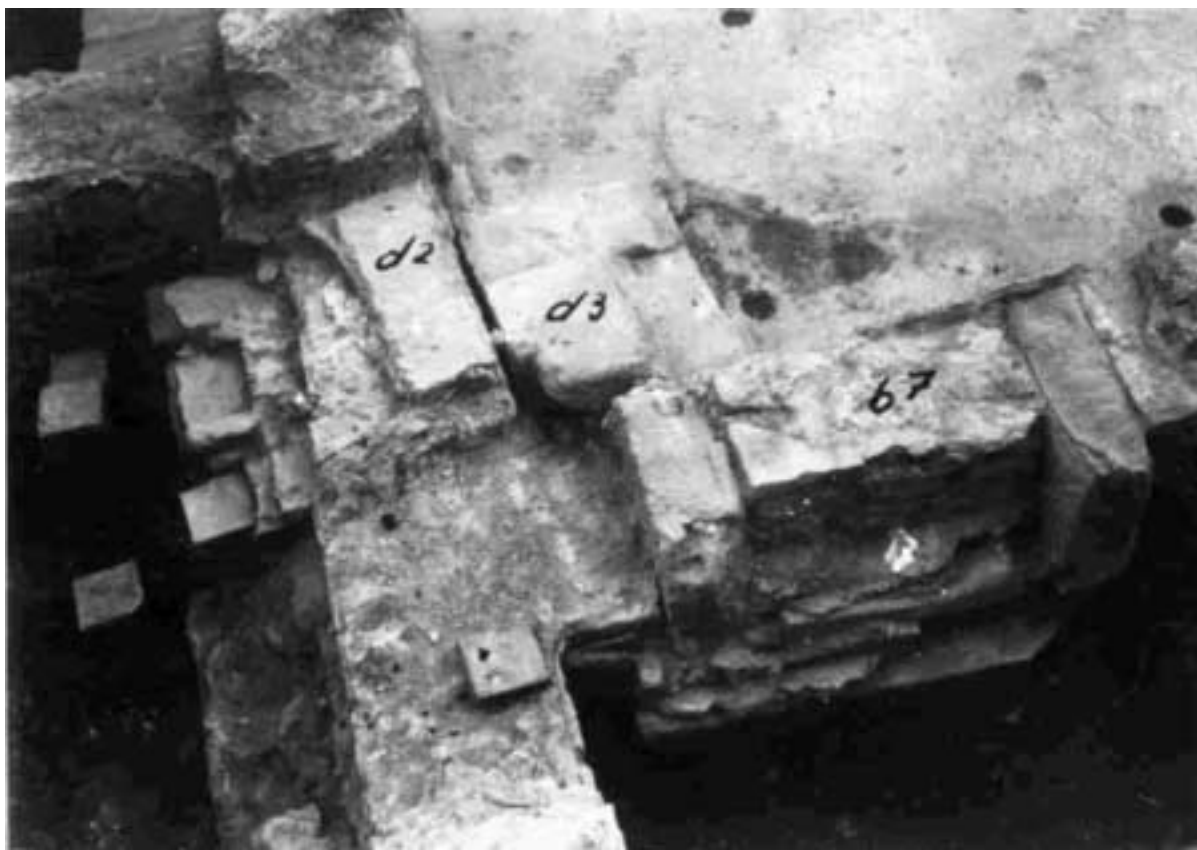
Abb. 37. Türen T2 und T5 (von Nordosten)
