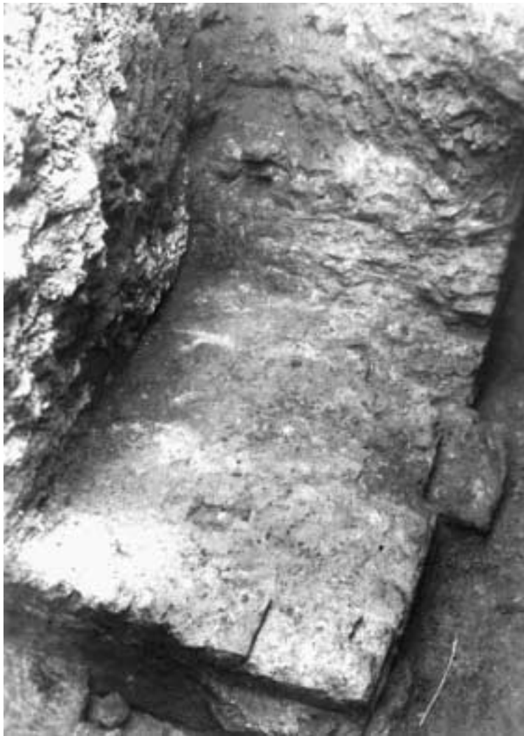
Abb. 27. Ostecke des Unterbaus der Kesselanlage im Heizraum P1 (von Osten)
