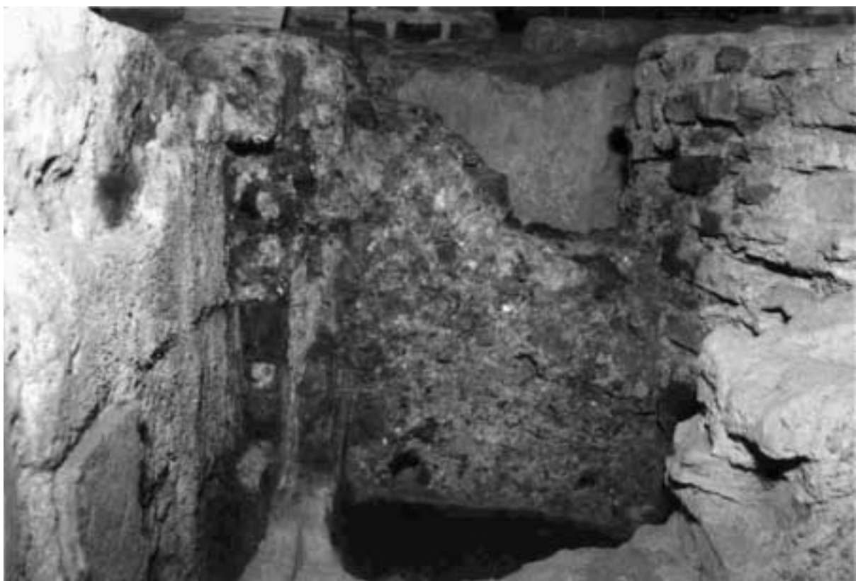
Abb. 16. Mauerwerk zum Schutz des Abflusses aus dem Alveus W1
