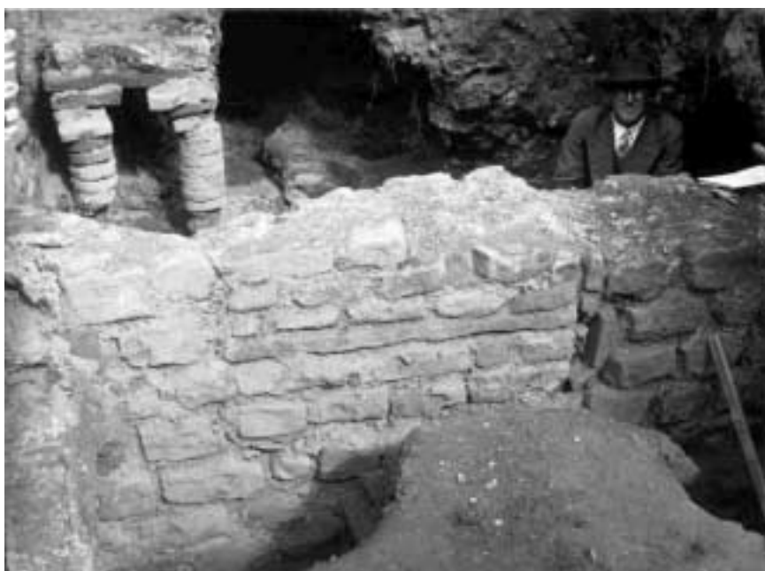
Abb. 50. Tür T4 zwischen Tepidarium und Raum E, jüngerer Zustand (von Westen)
