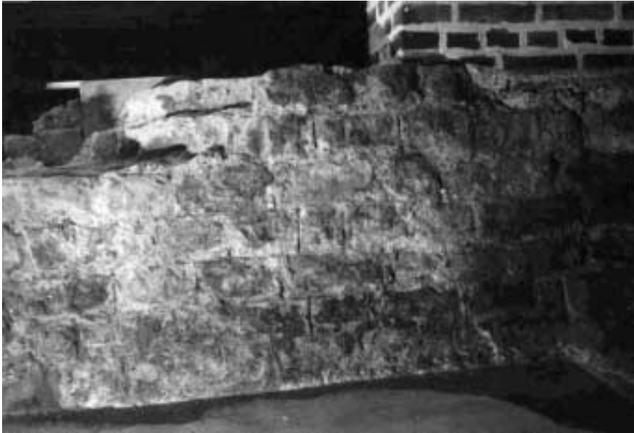
Abb. 1. Außenseite der Nordmauer des Caldarium mit Fugenstrich
