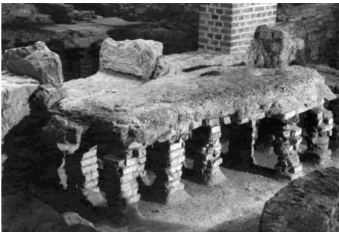
Abb. 30. Nordostecke des Tepidarium, intaktes Stück der Hypokausten (von Südwesten)
