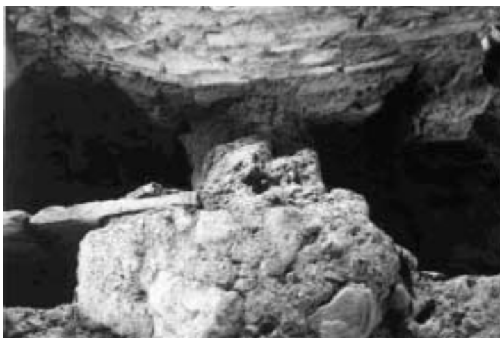
Abb. 14. Ummantelung des Abflußrohres aus dem Alveus W1(von oben)
