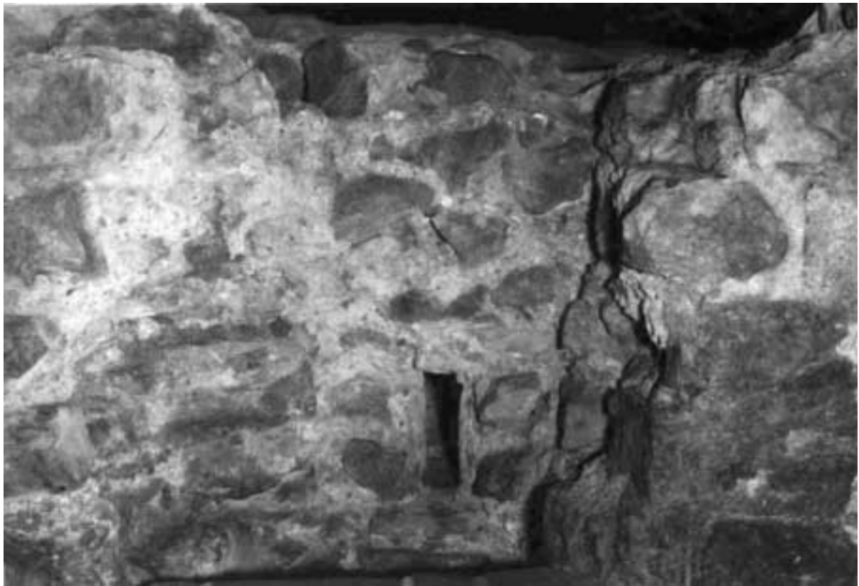
Abb. 15. Öffnung in der Westmauer von W1 für das Abflußrohr
