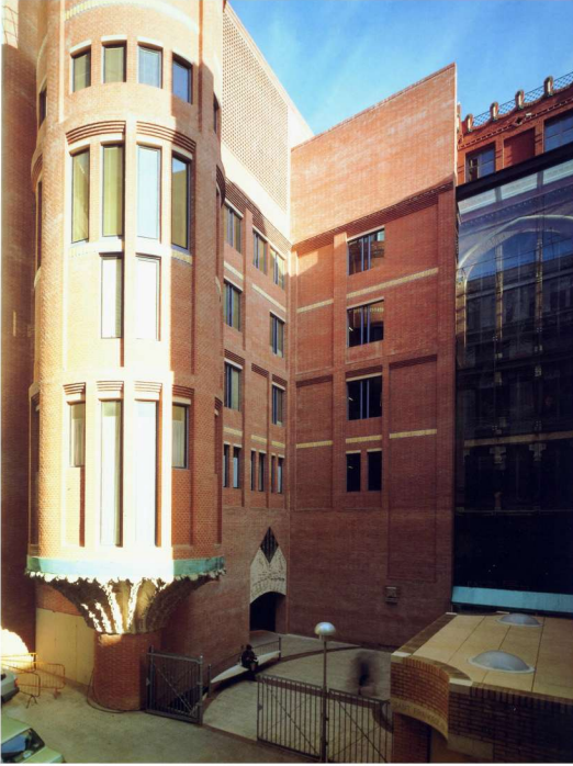
Abb. 41 Neue Administrativtrakte von Oscar Tùsquets mit Rundturm in der Art Domènech i Montaners
