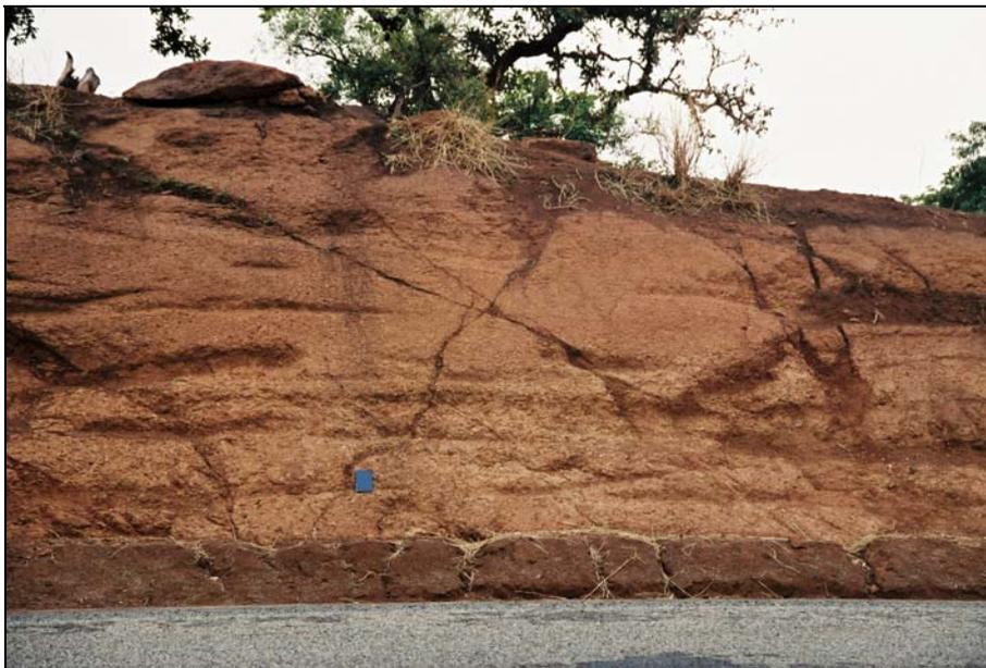
Abb. 7.17: Klüfte und Wegsamkeiten (präferentielle Fließwege) in der ungesättigten saprolitischen Verwitterungszone (Trockenzeit 2002) an der Autopiste zwischen Bassila und Djougou.
