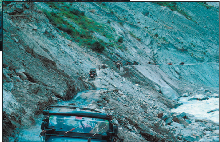
Abb. 5.3.2.25: Unsicherer Straßenverlauf der neuen Astor Straße unterhalb von Mushkin (oben: Blick von der alten Astor Straße astoraufwärts Richtung SE, Foto: R. Spohner 04.09.1995 - roter Pfeil: Standort und Blickrichtung für Foto rechts; rechts: einspuriger Verkehr mit wechselnder Richtung auf der ständig abrutschgefährdeten neuen Straße, Foto: R. Spohner 23.09.1995)
