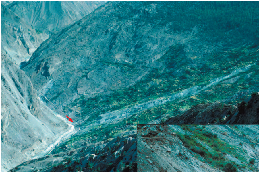
Abb. 5.3.2.25: Unsicherer Straßenverlauf der neuen Astor Straße unterhalb von Mushkin (oben: Blick von der alten Astor Straße astoraufwärts Richtung SE, Foto: R. Spohner 04.09.1995 - roter Pfeil: Standort und Blickrichtung für Foto rechts; rechts: einspuriger Verkehr mit wechselnder Richtung auf der ständig abrutschgefährdeten neuen Straße, Foto: R. Spohner 23.09.1995)
