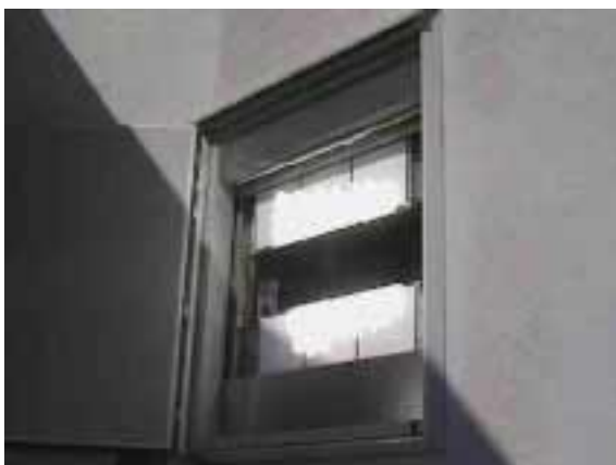
Abbildung 2.16: Sicht von außen auf die weiß reflektierenden Flächen des halb geöffneten Shutters.
