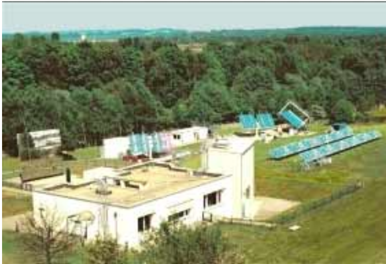
Abbildung 2.10: Im Vordergrund das DLR Sonnenofengebäude mit Heliostat (links). Dahinter weitere solarchemische und solarthermische Testanlagen.
