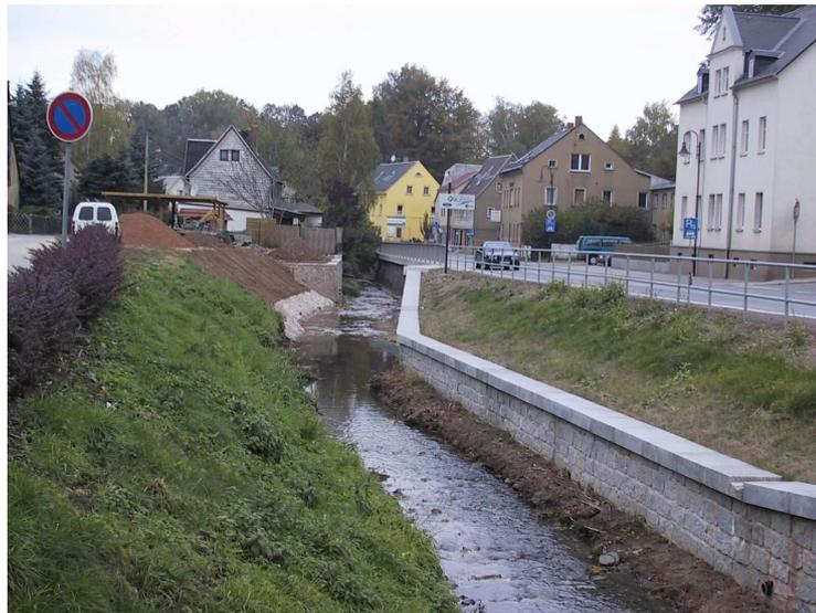
Abb. 7.6: Wiederaufbau der vom Hochwasser im August 2002 zerstörten Sicherungsanlagen am Beispiel des Lungwitzbachs in Oberlungwitz im Oktober 2003.
