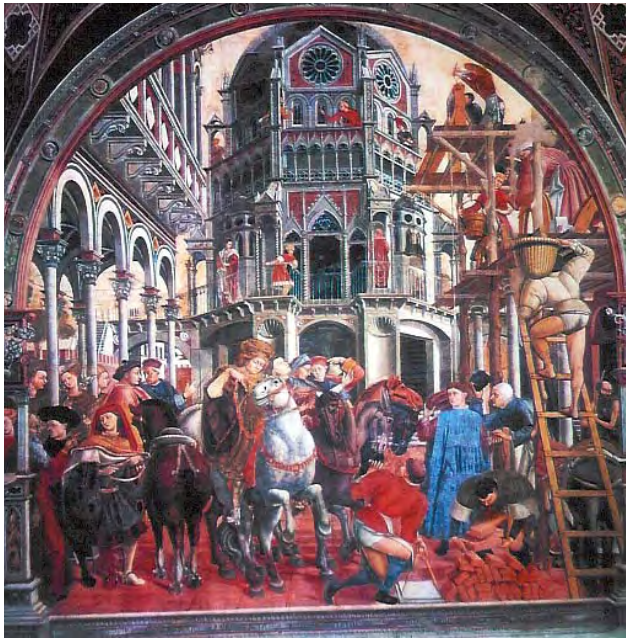
Abb. 129: Siena, Ospedale della Scala, Pellegrinaio, Fresken der Südostwand
