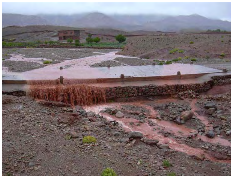
Abbildung 4.18 Überflutete Straße bei Alemdoun zwischen dem Ameskartal und Ifre während des großen Niederschlagsereignisses am 28.3.2004 (Foto: O. Schulz).
