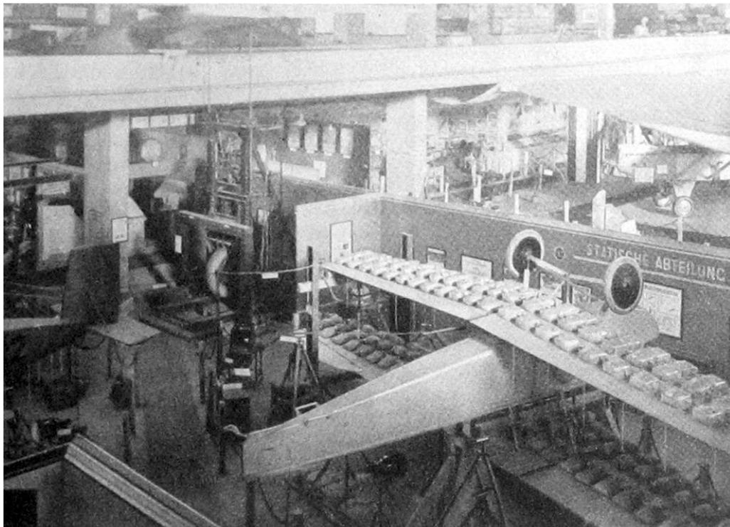
Messestand der DVL auf der Internationalen Luftfahrt Ausstellung in Berlin 1928. Vorn eine Junkers T 26 bei der Belastungsprüfung, hinten links ein in einen 3-t-Fallhammer eingespanntes Laufrad eines Flugzeugs.
