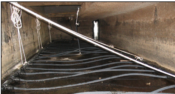
Abb.12: Installation der Belüftungsgitter im FM-Kanal des Versuchsabteils
