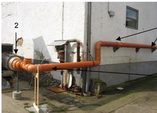
Abb.15: Unterflurabsaugung im Außenbereich bis zum Wäscher
