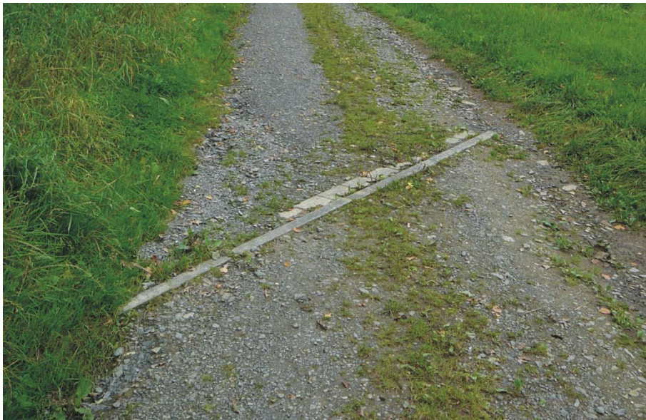
Abbildung 94: Drainage auf einem ca. 2,5 m breiten Weg im Steinersiefen Teileinzugsgebiet (September 2007)
